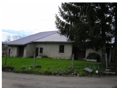
Façade postérieure. Phot. Marie-Pierre Reynet IVR43_20083900180NUC1A
