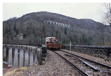
Draisine sur le viaduc de Morez.
