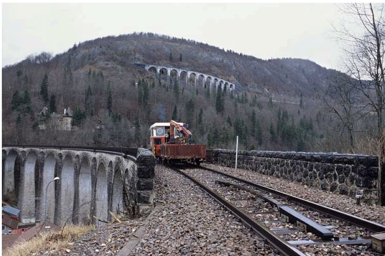
Draisine sur le viaduc de Morez.
