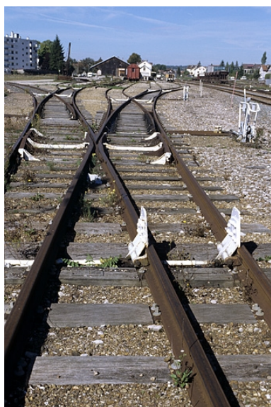
Gare de Champagnole : vue d'ensemble des voies de service ouest, avec les taquets d'arrêt au premier plan. Phot. Yves Sancey IVR43_20043900177ZA
