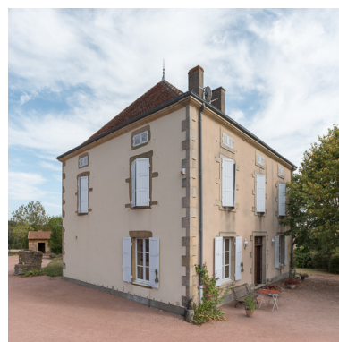
Vue de la façade antérieure de la demeure, construite à la fin du XIXe siècle, et de sa façade latérale ouest Phot. Pierre-Marie Barbe-Richaud IVR26_20197100336NUC4A
