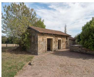
Vue du bâtiment abritant le four à pain et les soues à cochons, à l'est de la cour Phot. Pierre-Marie Barbe-Richaud IVR26_20197100343NUC4AQ
