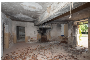
Vue de la pièce principale (cuisine) de l'ancienne maison Phot. Pierre-Marie Barbe-Richaud IVR26_20197100349NUC4A
