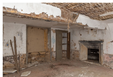
Vue d'une chambre, au rez-de-chaussée de l'ancienne maison, à droite de la cuisine Phot. Pierre-Marie Barbe-Richaud IVR26_20197100353NUC4A
