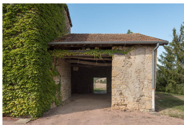
Vue du hangar agricole, construit contre le mur-pignon est de l'ancienne maison Phot. Pierre-Marie Barbe-Richaud IVR26_20197100344NUC4A
