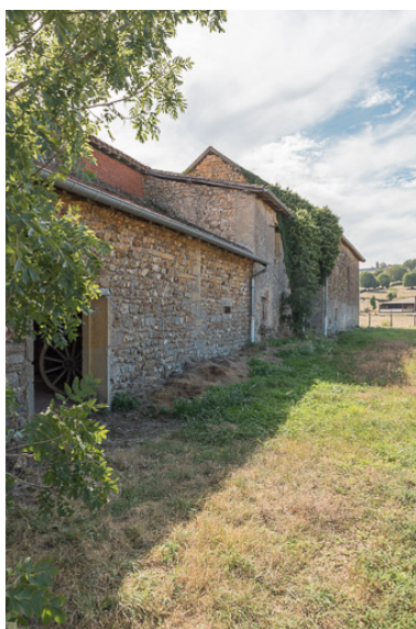
Vue de la façade postérieure du même ensemble: de gauche à droite, le hangar agricole, l'ancienne maison avec son appentis et la grange Phot. Pierre-Marie Barbe-Richaud IVR26_20197100342NUC4A
