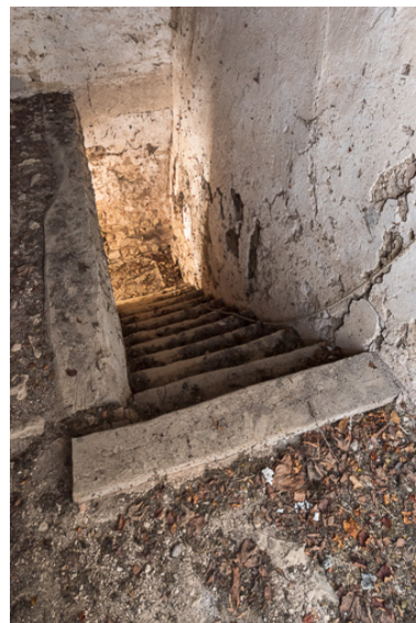
Escalier de l'ancienne maison, à deux volées droites Phot. Pierre-Marie Barbe-Richaud IVR26_20197100355NUC4A
