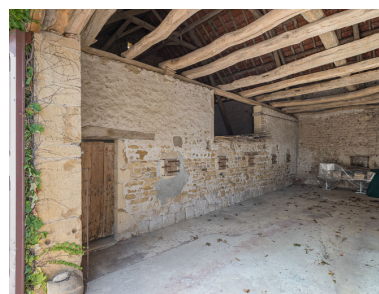
Vue intérieure de la grange. Le mur entre la remise et l'étable est percé de feurons. Phot. Pierre-Marie Barbe-Richaud IVR26_20197100341NUC4A
