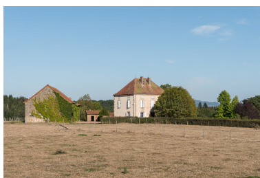
Vue de l'ancienne ferme de Parigny Phot. Pierre-Marie Barbe-Richaud IVR26_20197100357NUC4A
