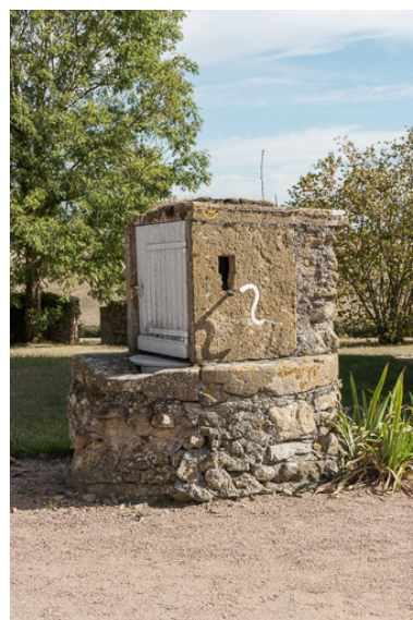
Vue du puits, dans la cour Phot. Pierre-Marie Barbe-Richaud IVR26_20197100347NUC4A
