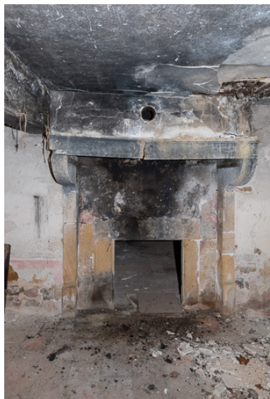
Vue de la cheminée de la cuisine, dans l'ancienne maison. Il s'agit d'un foyer double, donnant à la fois dans la cuisine et dans la pièce voisine. L'âtre est percé d'une ouverture, fermée d'une plaque en fonte. Ce type de cheminée est assez répandu dans l'architecture rurale du Brionnais des XVIIIe et XIXe siècles. Phot. Pierre-Marie Barbe-Richaud IVR26_20197100351NUC4A
