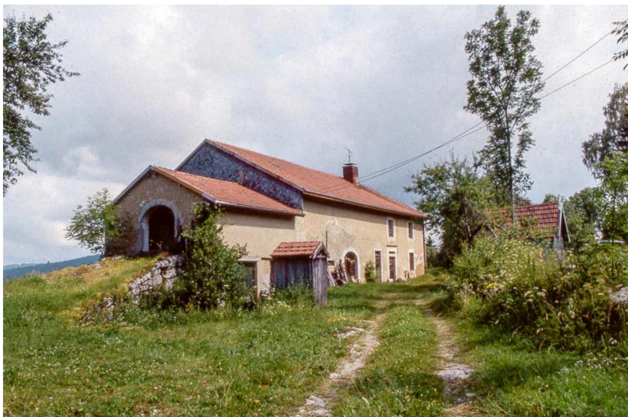
Vue éloignée de la façade antérieure.
