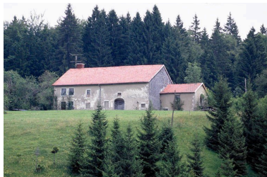
Vue éloignée de la façade postérieure.
