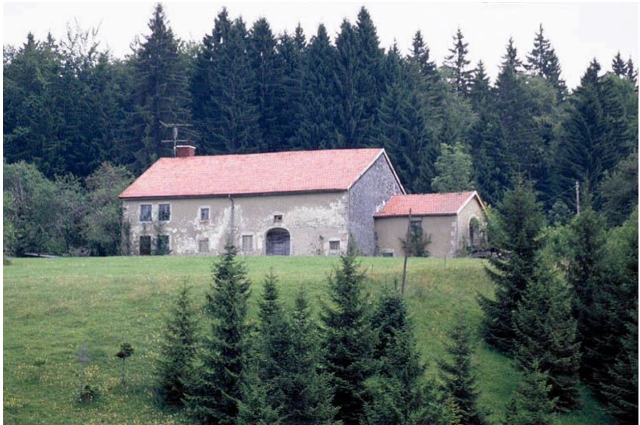
Vue éloignée de la façade postérieure.
