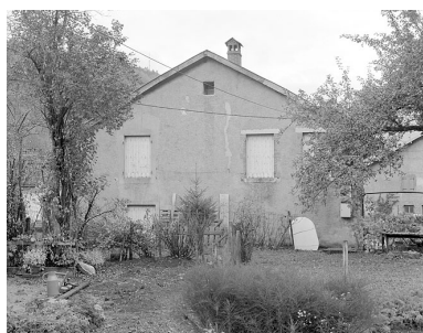
Face sud. Phot. Jérôme Mongreville IVR43_19963901638X
