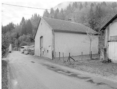
Face nord et façade postérieure. Phot. Jérôme Mongreville IVR43_19963901641X
