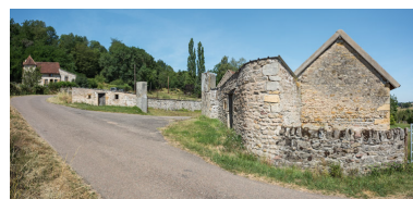
Vue sur l'entrée de la ferme. Le bâtiment agricole, au fond à gauche, a notamment servi de bergerie et a été rattaché à cette ferme au milieu du XIXe siècle. Il est aujourd'hui transformé en habitation. Phot. Pierre-Marie Barbe-Richaud IVR26_20197100151NUC4AQ
