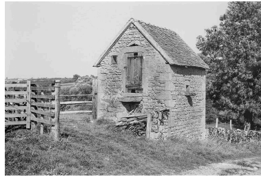
Vue d'un édicule à l'entrée d'un pré de la propriété, mentionné dans certaines sources comme bergerie, mais qui a pu aussi servir d'abri aux gardes de pré. Phot. Raymond Oursel IVR26_20207100100NUC2
