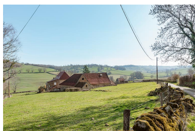
Vue de la ferme depuis la route, en venant de Chaumont. Plusieurs volumes (principalement en appentis) se développent à l'arrière des bâtiments principaux. Phot. Pierre-Marie Barbe-Richaud IVR26_20197100738NUC4A
