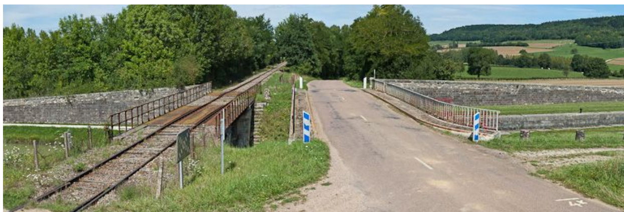
Vue des deux ponts sur écluse.
