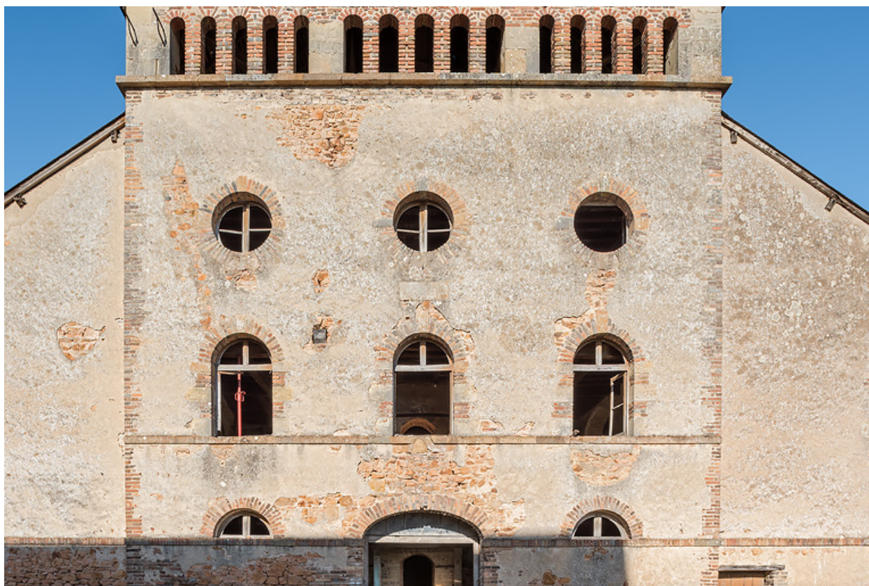
Baies du deuxième et du troisième niveau.
