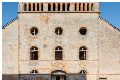
Baies du deuxième et du troisième niveau. Phot. Pierre-Marie Barbe-Richaud IVR26_20195800715NUC4A
