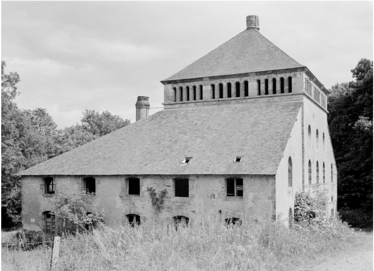
Vue depuis le nord-ouest, état en 1977.
