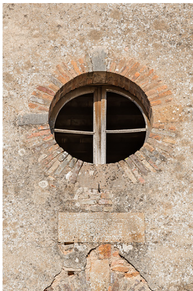
Oculus du troisième niveau. Phot. Pierre-Marie Barbe-Richaud IVR26_20195800716NUC4A
