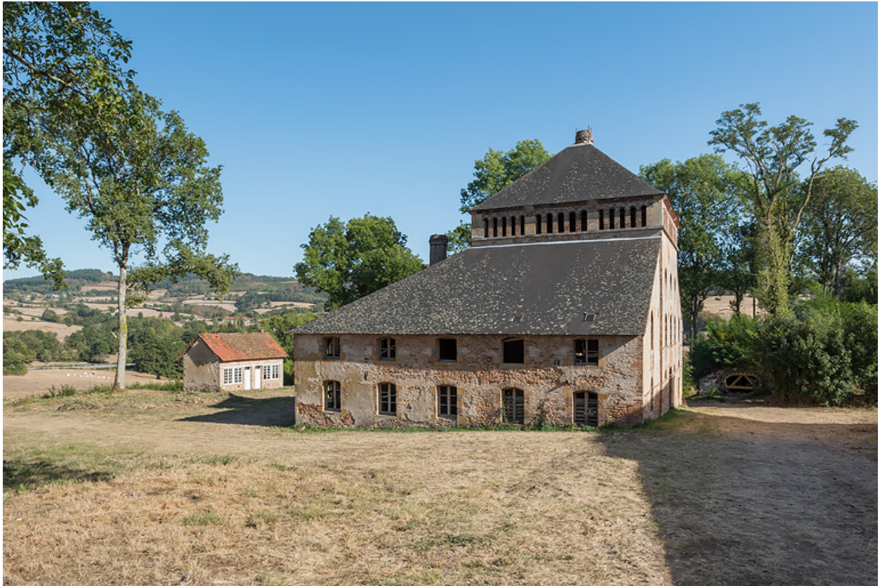
Vue depuis le nord-ouest, état actuel.
