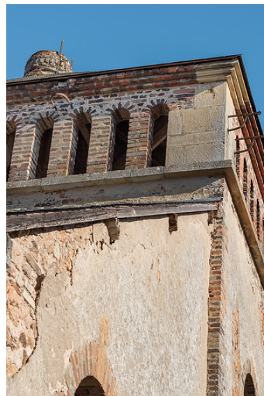
Claire-voie du quatrième niveau. Phot. Pierre-Marie Barbe-Richaud IVR26_20195800717NUC4A
