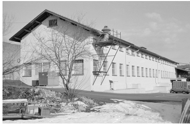
Atelier de fabrication (P). Phot. Laurent Poupard IVR43_19923901135Z
