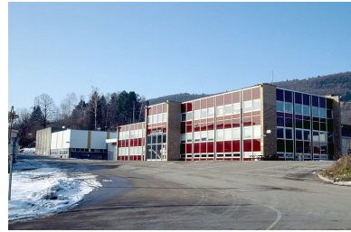
Atelier de fabrication (L) et bureau (O). Phot. Laurent Poupard IVR43_19923901137ZA
