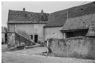
Vue d'ensemble. Phot. Bernard Lardière IVR43_19817000476Z
