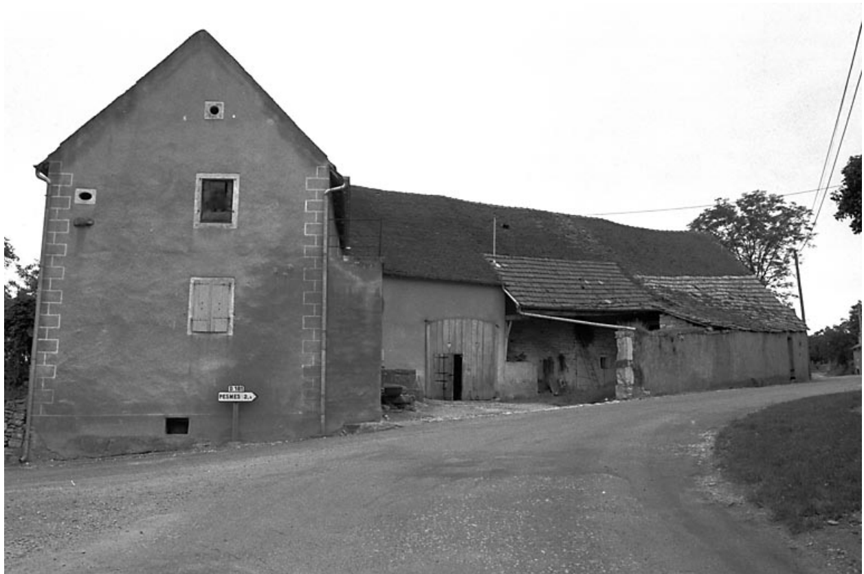
Vue d'ensemble depuis la rue.
