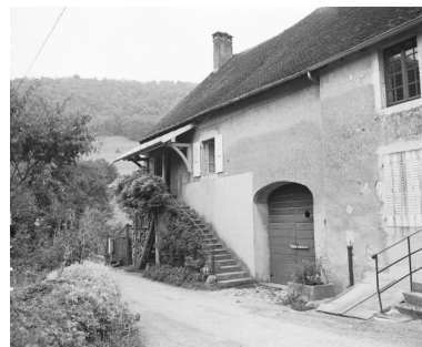
Ferme située rue du Côteau. Phot. Yves Sancey IVR43_19793900128X
