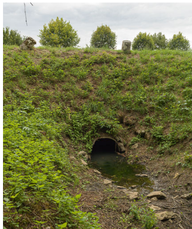
Vue de l'aqueduc.
