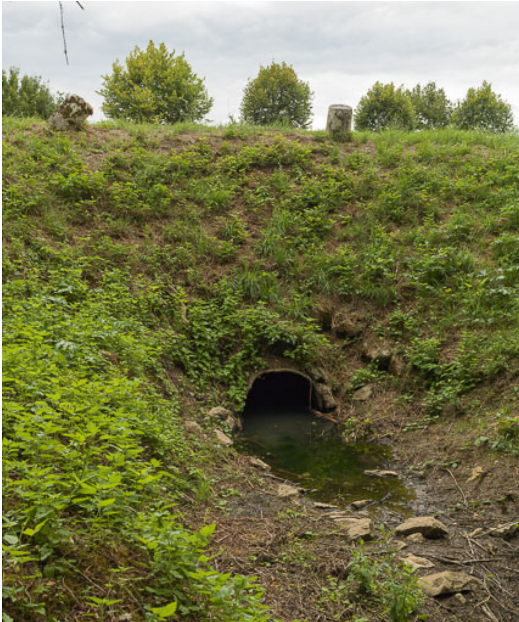
Vue de l'aqueduc.
