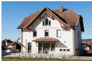
Vue de trois quarts droite. Phot. Jérôme Mongreville IVR43_20152502406NUC4A
