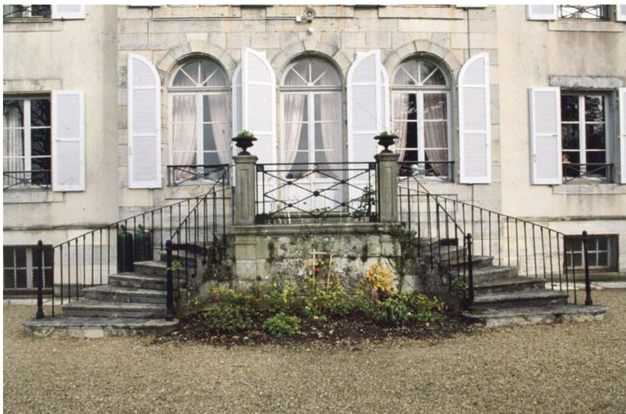
Détail de la façade ouest.
