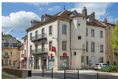
Trois quarts droit de la maison. Phot. Jérôme Mongreville IVR43_20227000026NUC4A
