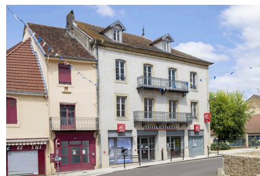
Trois quarts gauche de la maison et des n° 1 et 3 rue de l'Hôtel-de-ville. Phot. Jérôme Mongreville IVR43_20227000028NUC4A
