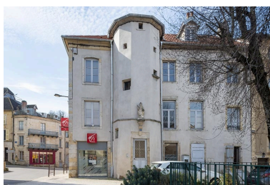
Façade orientale de la maison. Phot. Jérôme Mongreville IVR43_20227000030NUC4A
