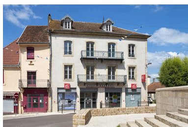
Façade de la maison. Phot. Jérôme Mongreville IVR43_20227000027NUC4A
