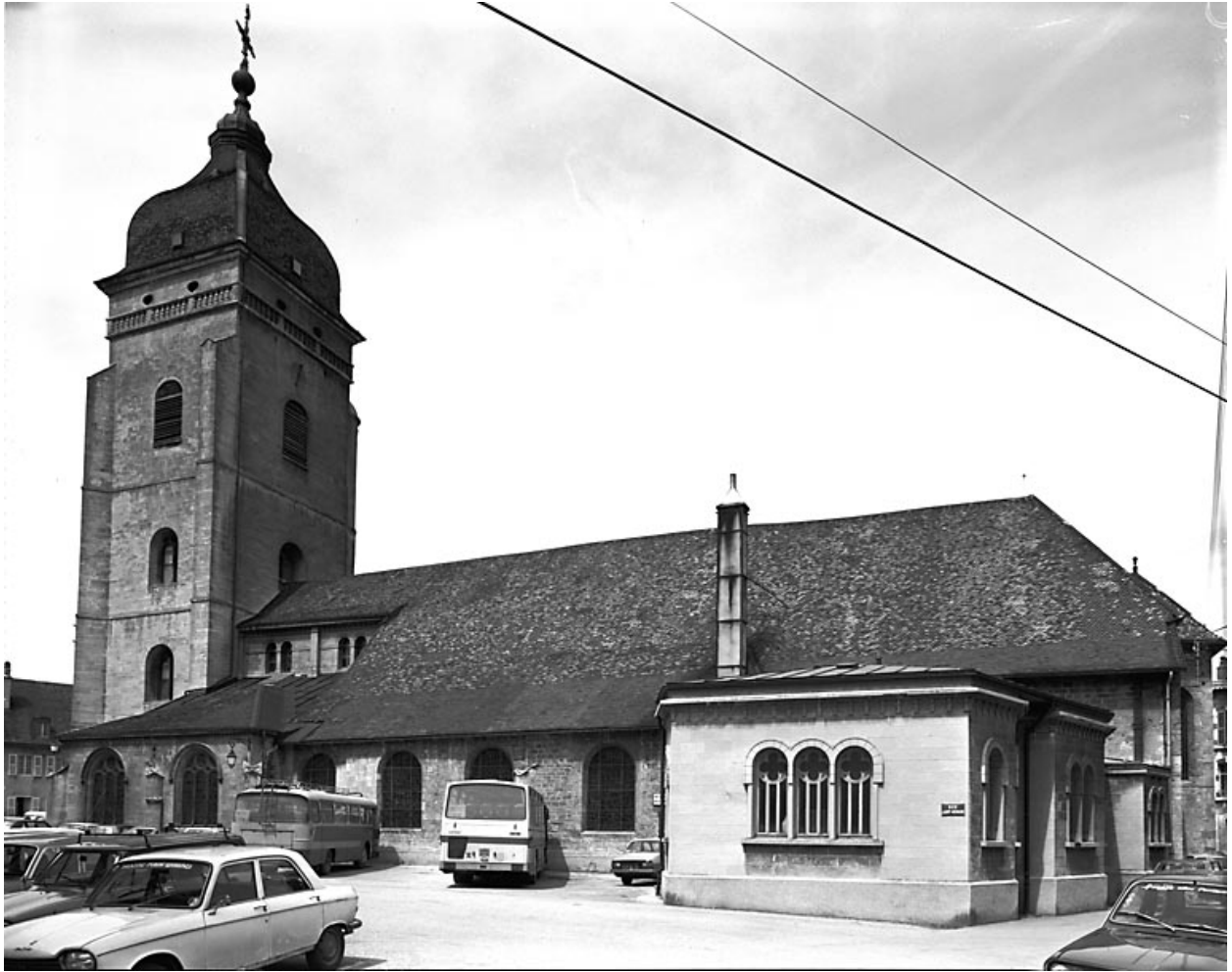
Façade latérale droite.
