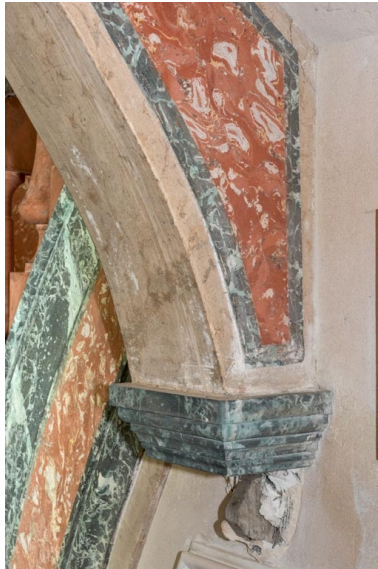
Décor de faux marbre du départ d'arc et de son culot. Phot. Pierre-Marie Barbe-Richaud IVR26_20212100521NUC4A
