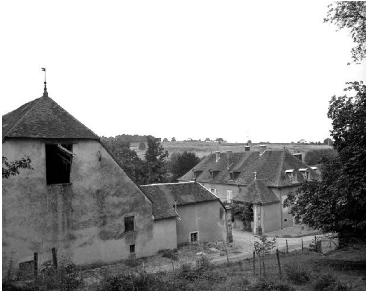
Vue depuis le sud-est.
