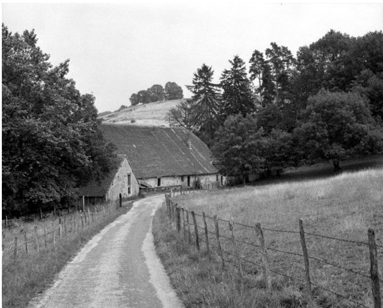
Les parties agricoles vues depuis l'ouest.
