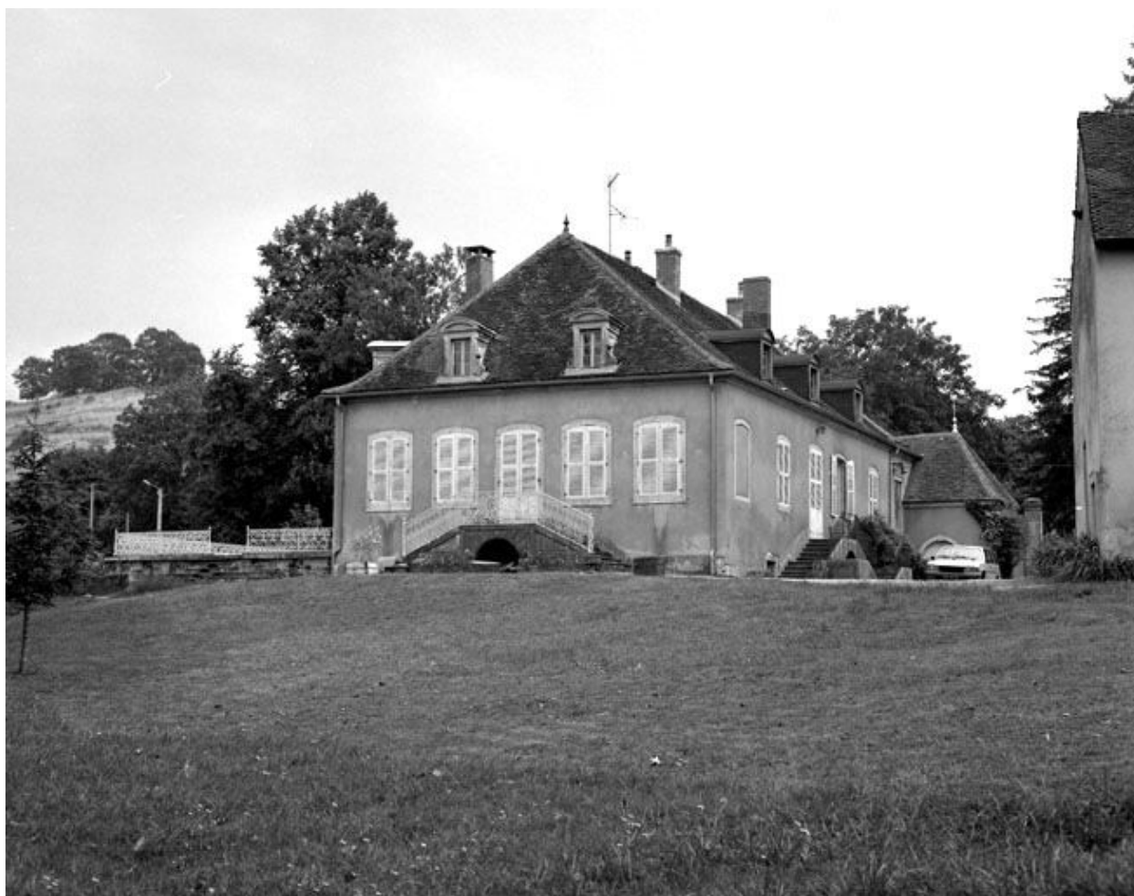
Façade droite du logis.
