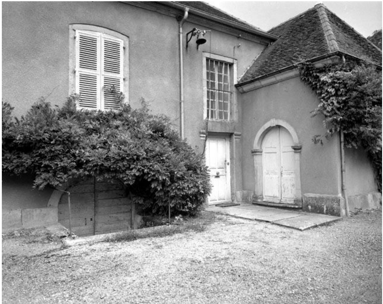
Façade antérieure du logis : partie droite.
