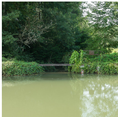
Vue du déversoir. Phot. Pierre-Marie Barbe-Richaud IVR26_20178900085NUC2A
