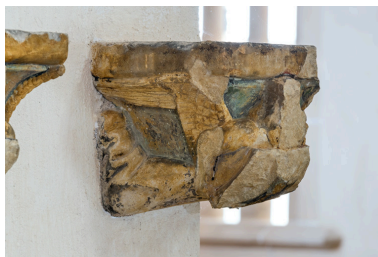
Culot de droite (vue de trois quarts depuis la gauche). Phot. Pierre-Marie Barbe-Richaud IVR26_20237100348NUC4A
