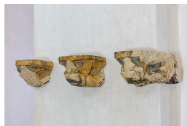
Vue d'ensemble des trois culots surmontant l'autel (vue de trois quarts depuis la droite). Phot. Pierre-Marie Barbe-Richaud IVR26_20237100342NUC4A
