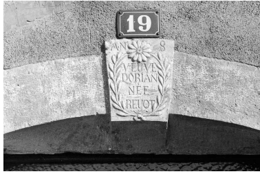
Porte d'habitation : détail. Phot. Bernard Lardière IVR43_19832500072Z
