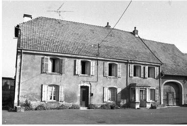
Vue d'ensemble. Phot. Bernard Lardière IVR43_19832500071Z
