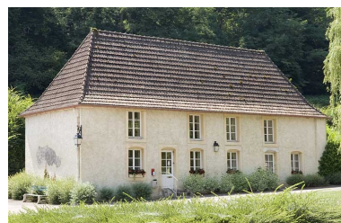
Dépendances sud. Phot. Jérôme Mongreville IVR43_20097000692NUC2A
