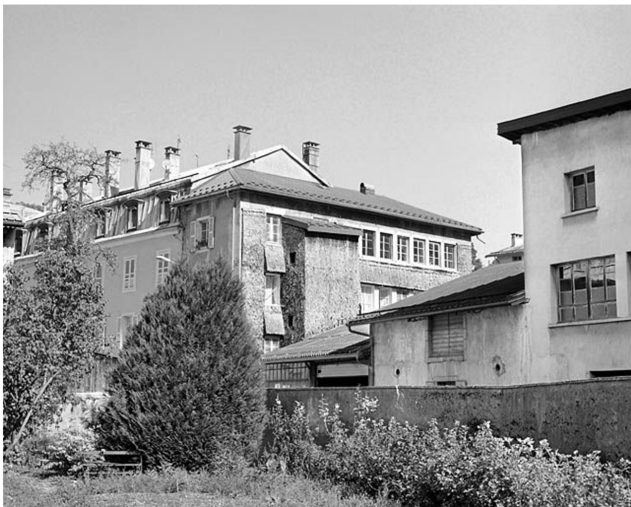
Façades antérieure et latérale droite.
