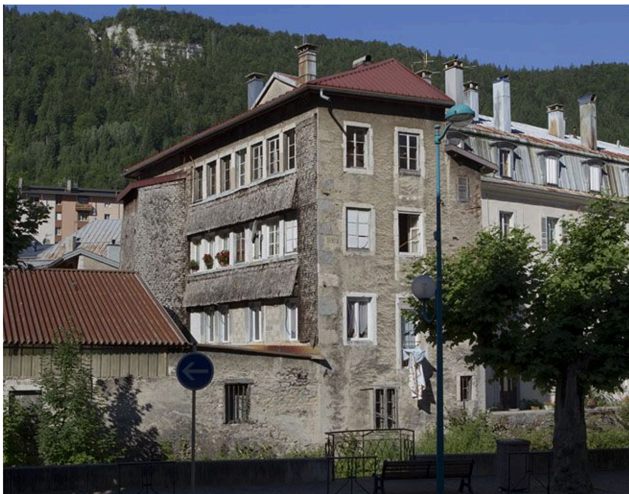
Façades postérieure et latérale droite.
