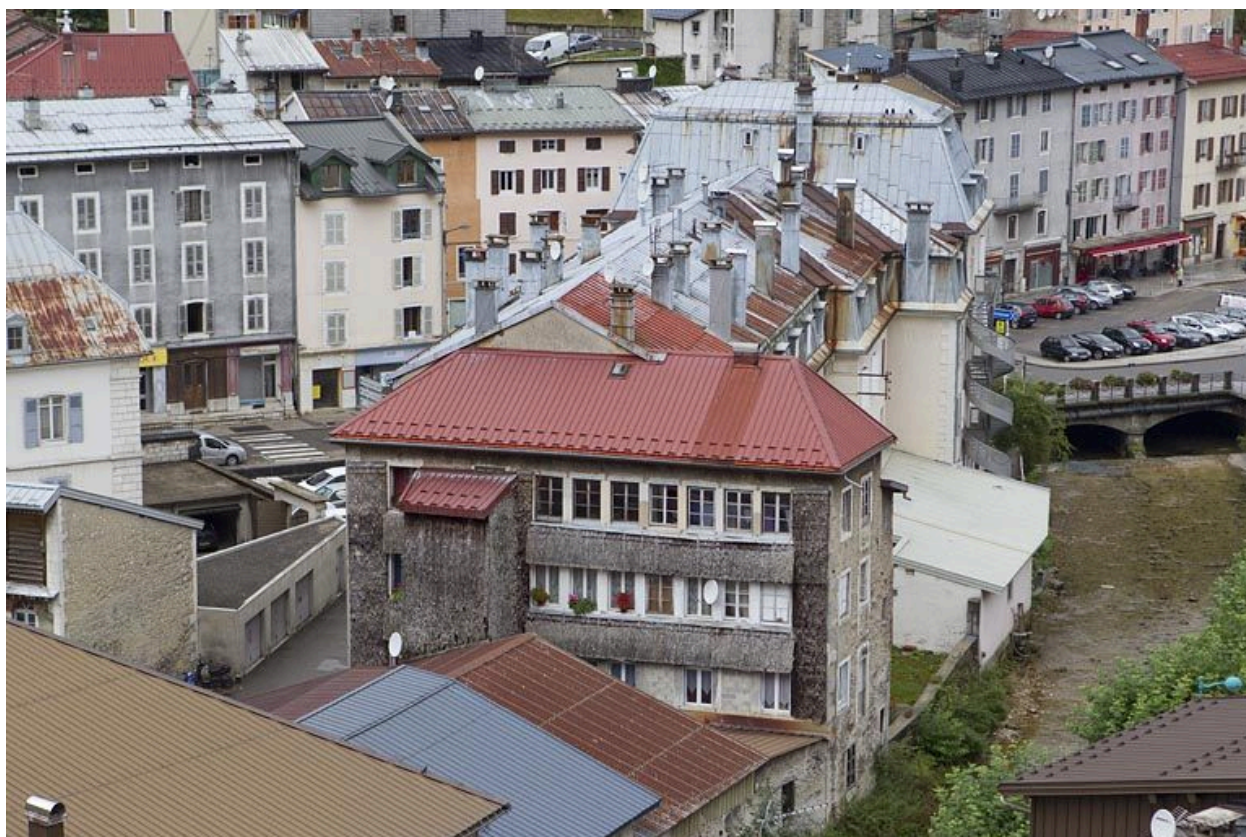
Vue d'ensemble plongeante, depuis l'est.
