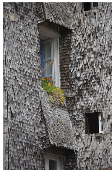
Détail des tavaillons et de la protection des fenêtres. Phot. Yves Sancey IVR43_20093900120NUC2A
