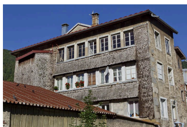
Façades postérieure et latérale droite.
