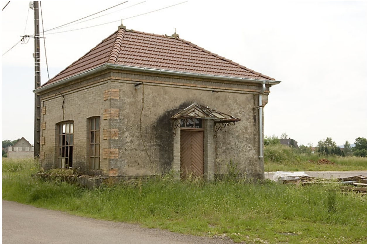
Local de la balance du pont bascule.
