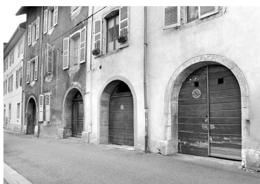
Maison au n° 30 : baies du rez-de-chaussée. Phot. Yves Sancey IVR43_20033900435X
