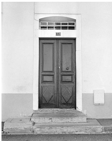
Maison au n° 32 : entrée principale. Phot. Yves Sancey IVR43_20033900430X
