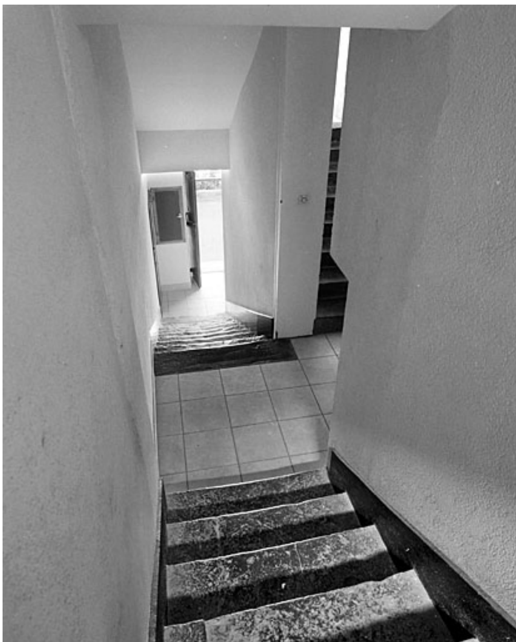
Maison au n° 32 : escalier.
