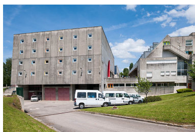
Pignons Sud des bâtiments, atelier et internat. Phot. Jérôme Mongreville IVR43_20143900298NUC4A
