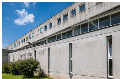
Bâtiment internat-administration Phot. Jérôme Mongreville IVR43_20143900325NUC4A
