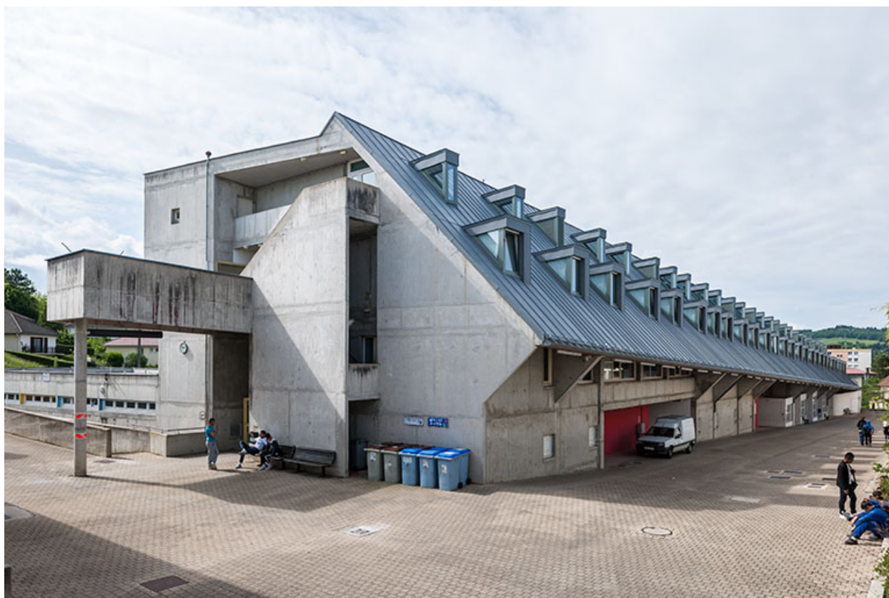
Façades et pignon nord du bâtiment internat-administration.
