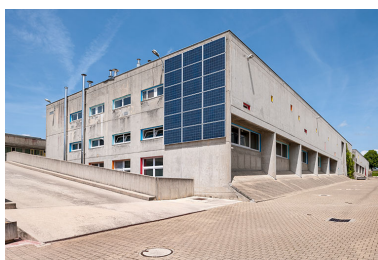
Atelier métal : pignon sud
