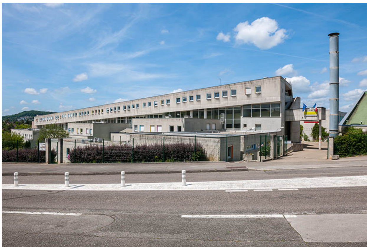
Vue générale depuis la rue Charles Ramey
