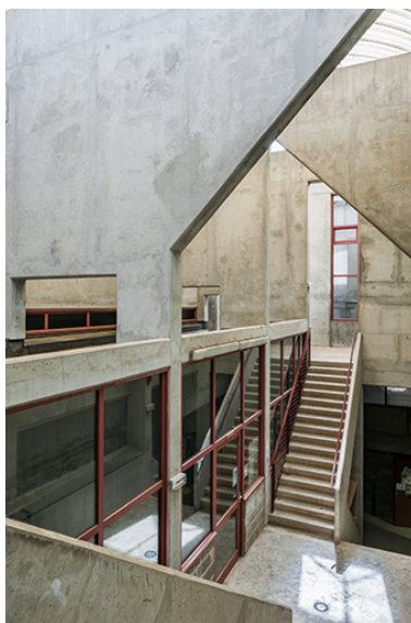
Atelier métal : cage d'escalier Phot. Jérôme Mongreville IVR43_20143900311NUC4A
