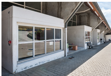
Façade en rez-de chaussée du bâtiment internat-administration Phot. Jérôme Mongreville IVR43_20143900331NUC4A
