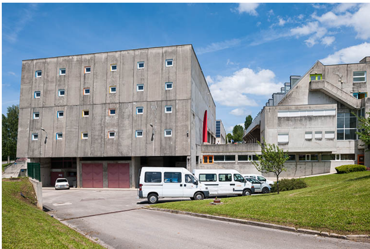
Pignons Sud des bâtiments, atelier et internat.
