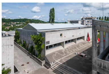
Atelier bois : vue générale Phot. Jérôme Mongreville IVR43_20143900306NUC4A
