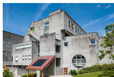
Pignon du bâtiment Phot. Jérôme Mongreville IVR43_20143900297NUC4A
