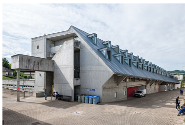
Façades et pignon nord du bâtiment internat-administration. Phot. Jérôme Mongreville IVR43_20143900321NUC4A
