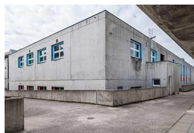
Atelier métal : façade latérale.
