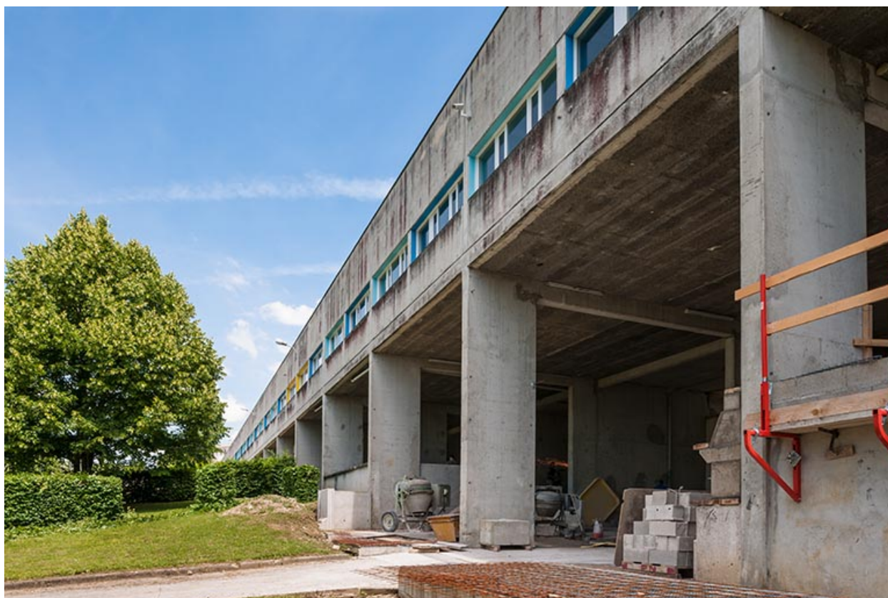
Externat : façade postérieure.
