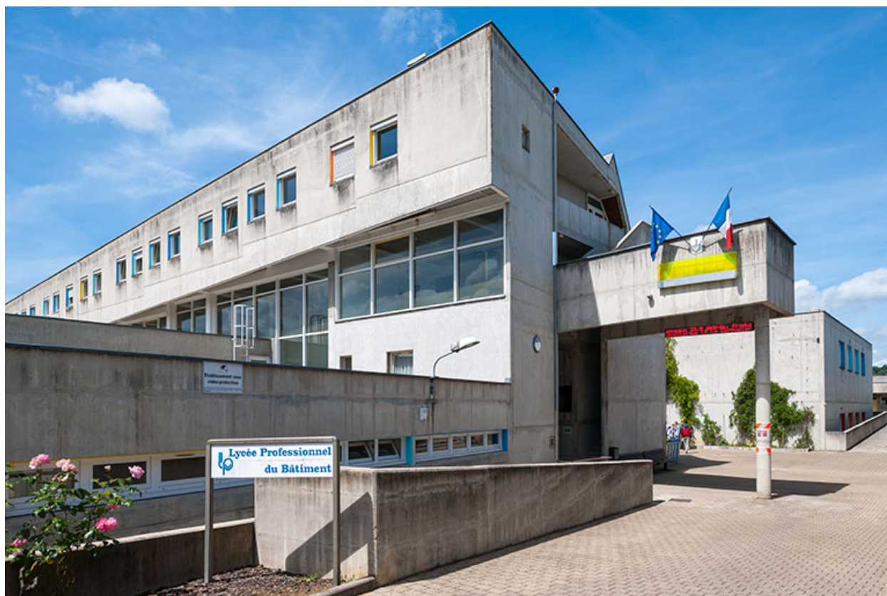
Entrée du lycée Le Corbusier: bâtiment administration
