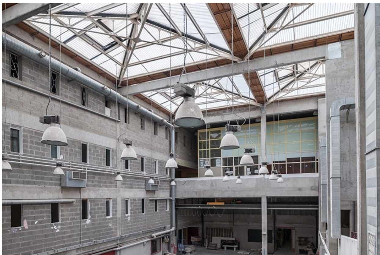
Atelier béton : intérieur, charpente et toiture.
