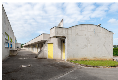
Externat : pignon nord Phot. Jérôme Mongreville IVR43_20143900317NUC4A
