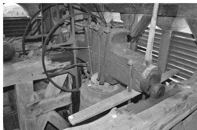
Vue d'ensemble, du sud-ouest. Phot. Jérôme Mongreville IVR43_20003900751Z
