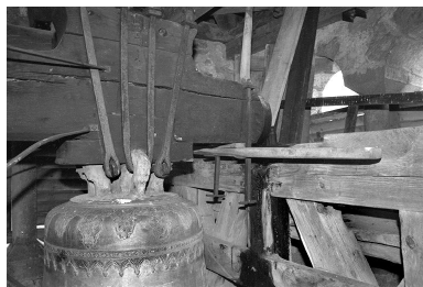
Mouton et anses, côté sud-ouest. Phot. Jérôme Mongreville IVR43_20003900752Z
