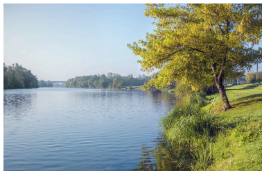
La Saône, avec en arrière- plan le pont de l'A39. Phot. Thierry Kuntz IVR26_20162101358NUC4A
