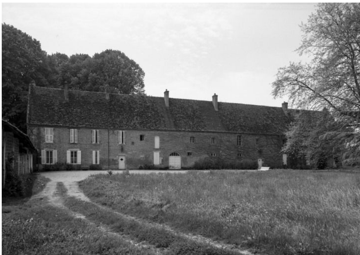
Bâtiment de l'ancien château, élévation sur cour.
