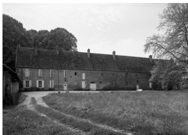
Bâtiment de l'ancien château, élévation sur cour.
