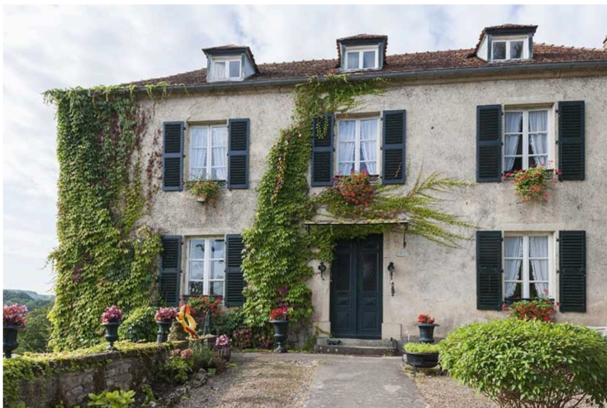
Façade antérieure sur cour.
