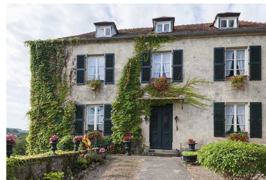
Façade antérieure sur cour. Phot. Jérôme Mongreville IVR43_20127000497NUC4A
