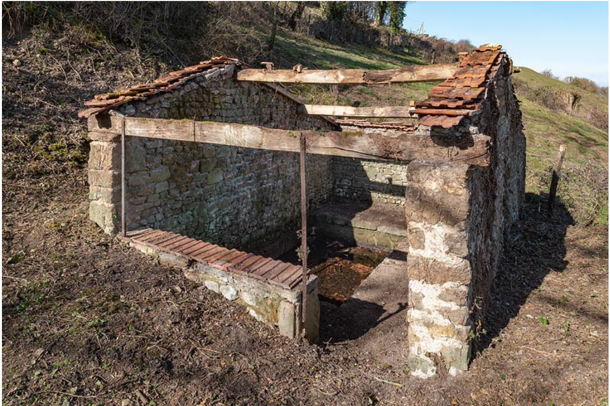
Lavoir du hameau (en cours de restauration)
