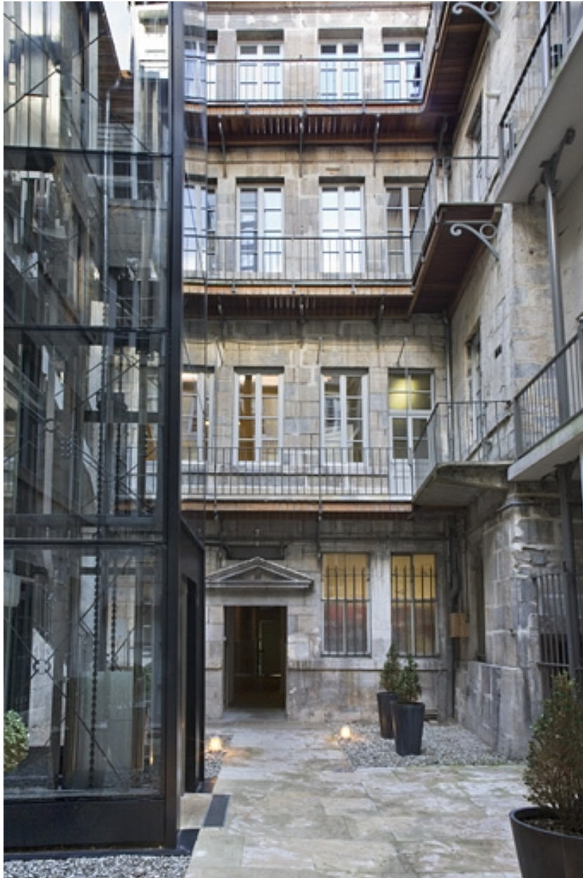
Vue d'ensemble des façades de l'hôtel depuis le fond de la cour.
