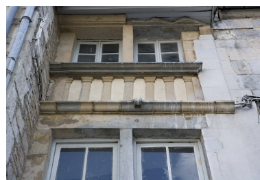
Détail du motif séparant le premier et le deuxième étage de l'entrée cochère.
