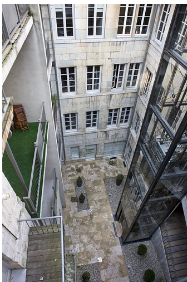
Vue d'ensemble de la façade antérieure du logis secondaire depuis la coursière du logis principal. Phot. Yves Sancey IVR43_20102500227NUC2A
