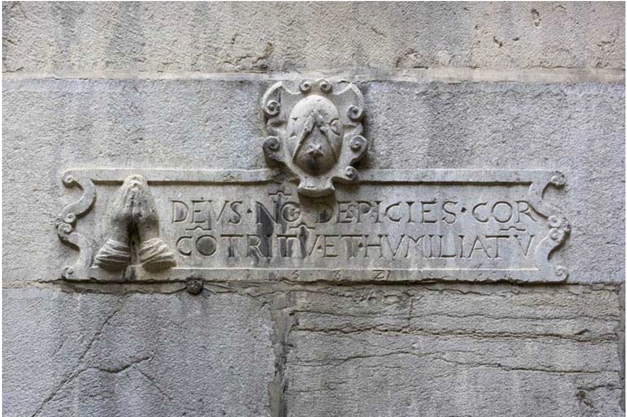
Façade antérieure du logis secondaire : détail d'une inscription.
