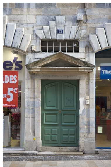
Façade antérieure du logis principal : détail de la porte d'entrée. Phot. Yves Sancey IVR43_20102500218NUC2A
