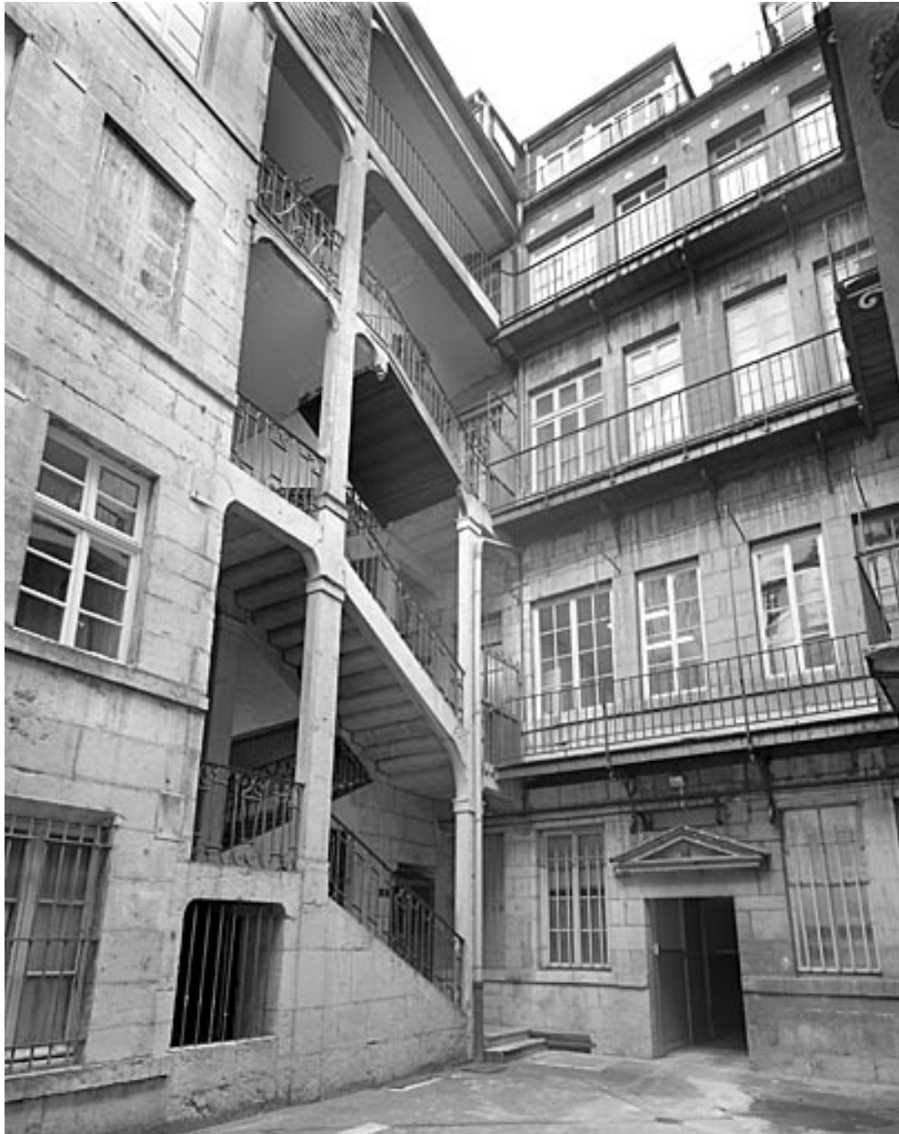
Vue d'ensemble de l'escalier à cage ouverte.
