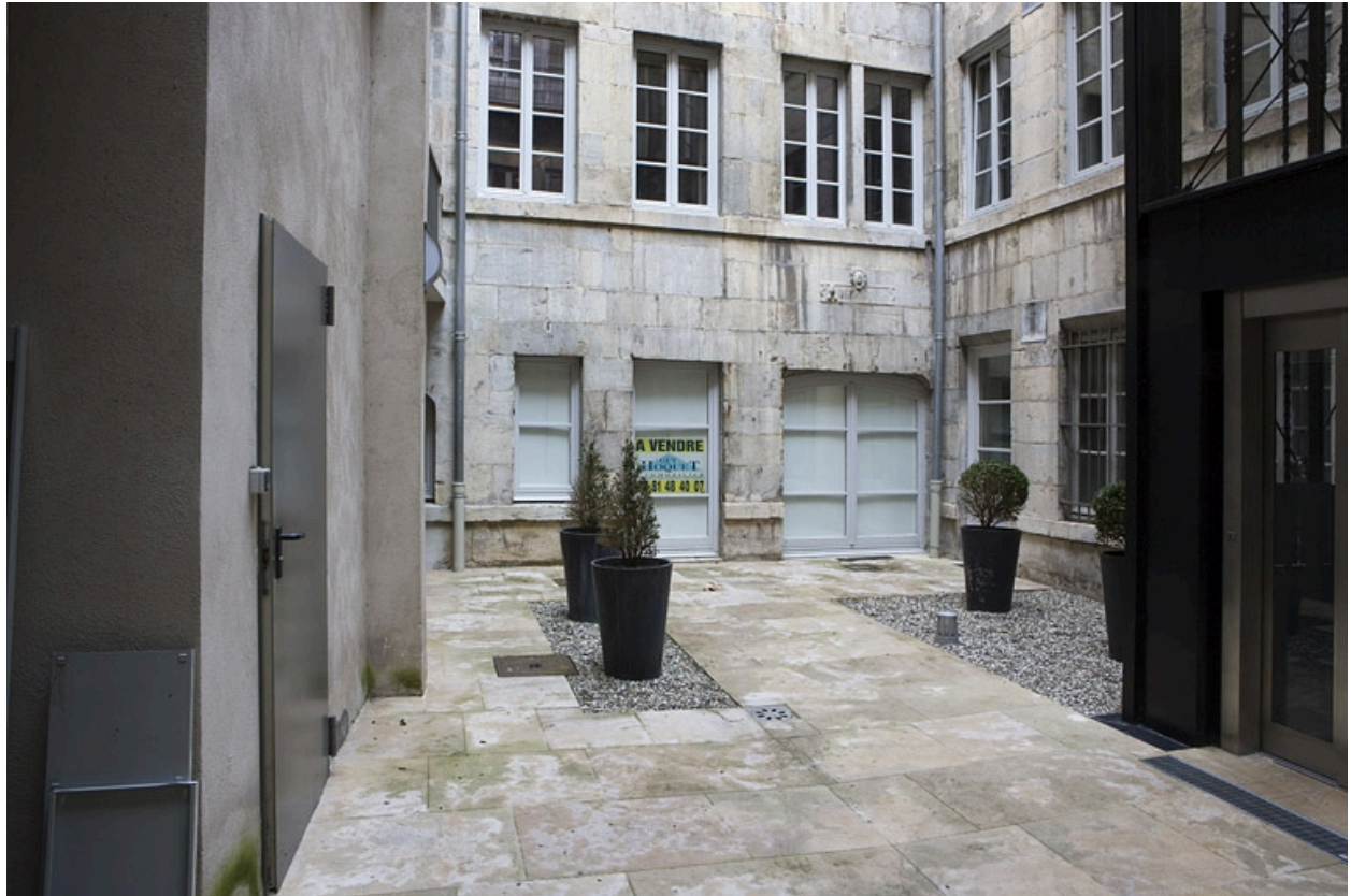
Façade antérieure du logis secondaire depuis l'entrée de la cour.
