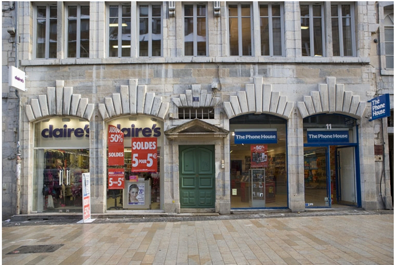
Façade antérieure du logis principal : détail du rez-de-chaussée.
