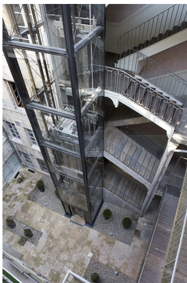
Vue d'ensemble de l'escalier à cage ouverte sur cour et de l'ascenseur. Phot. Yves Sancey IVR43_20102500226NUC2A
