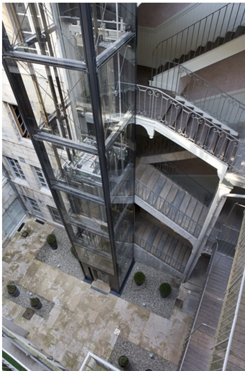
Vue d'ensemble de l'escalier à cage ouverte sur cour et de l'ascenseur.
