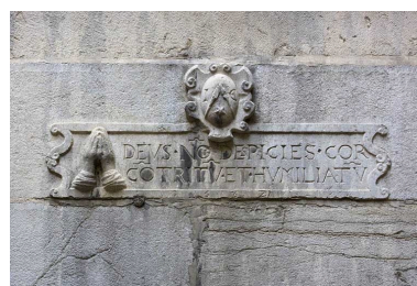
Façade antérieure du logis secondaire : détail d'une inscription. Phot. Yves Sancey IVR43_20102500224NUC2A
