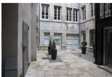
Façade antérieure du logis secondaire depuis l'entrée de la cour. Phot. Yves Sancey IVR43_20102500225NUC2A
