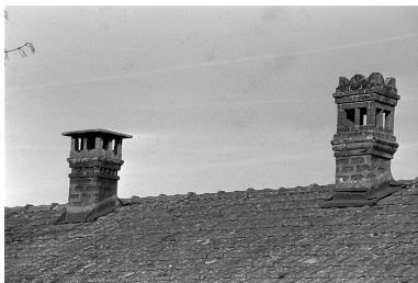
Souches des cheminées du logement. Phot. Laurent Poupard IVR43_19883900132Z
