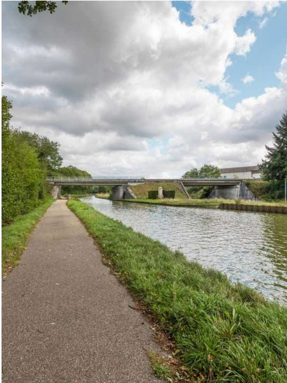
Vue d'ensemble du pont.
