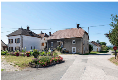
Bâtiments Grande Rue, aux n ° 53 (à gauche), 55 (au centre) et 66 (en retrait à droite). Phot. Sonia Dourlot IVR43_20192501304NUC4A
