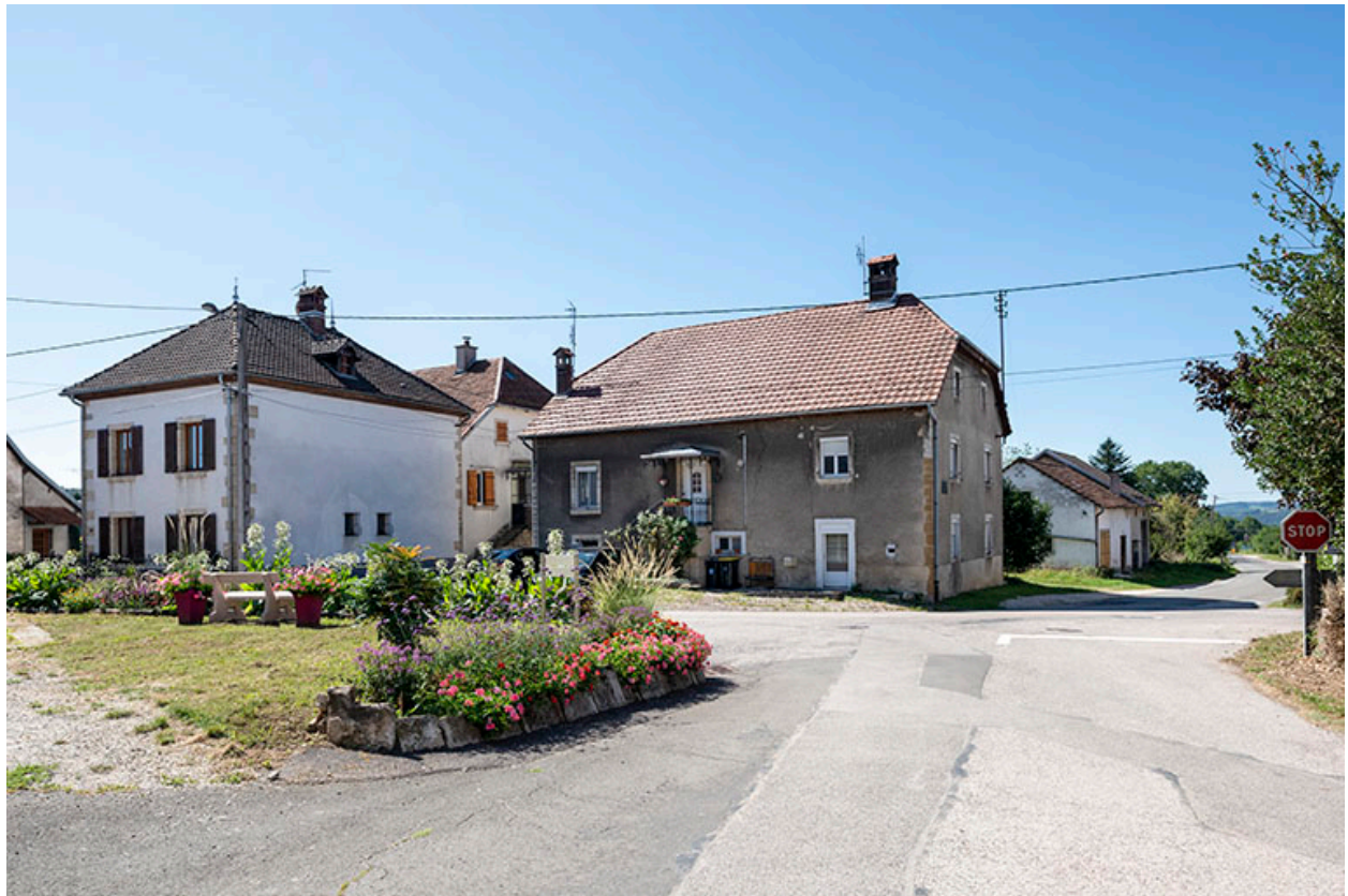
Bâtiments Grande Rue, aux n° 53 (à gauche), 55 (au centre) et 66 (en retrait à droite).
