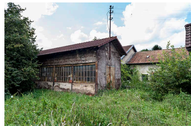
Site Mélières puis Gueutal (55 et 66 Grande Rue) : l'atelier de polissage. Phot. Sonia Dourlot IVR43_20192501314NUC4A
