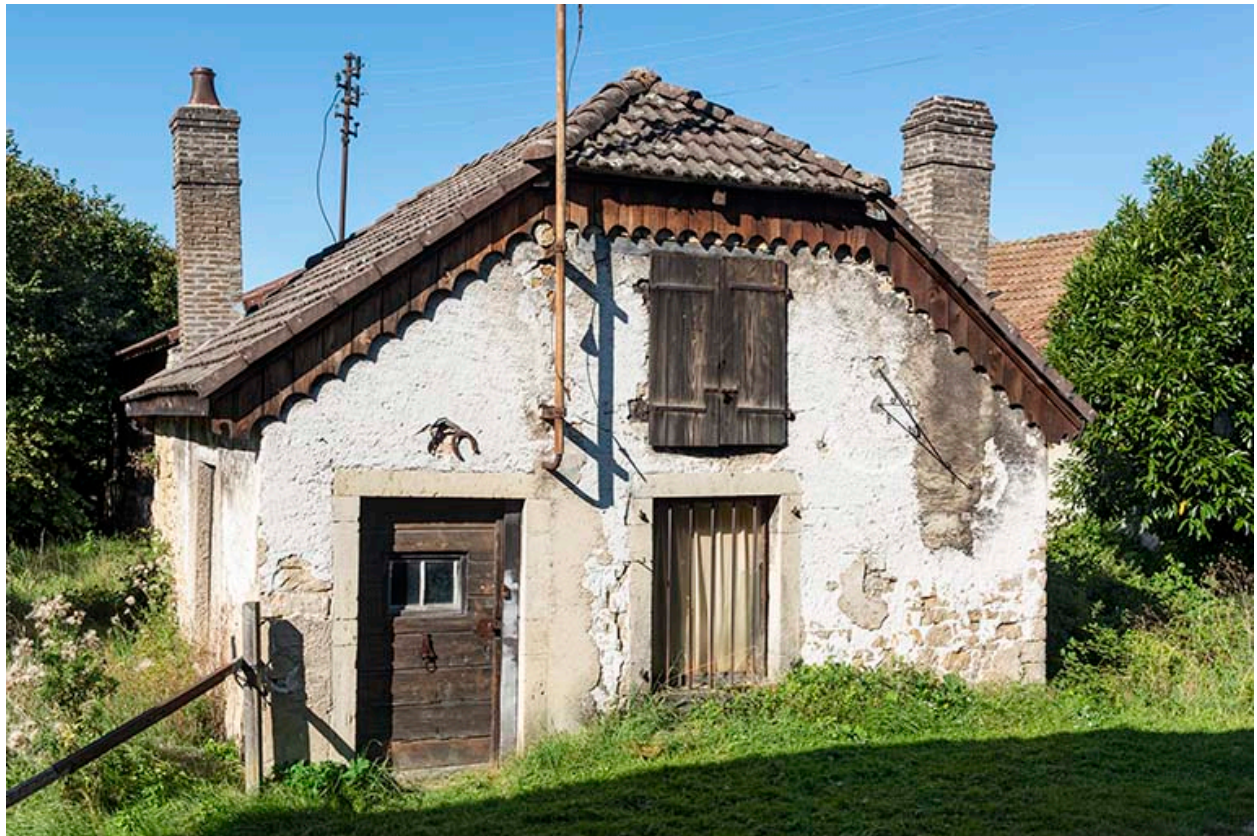
Site Mélières puis Gueutal (55 et 66 Grande Rue) : la forge.
