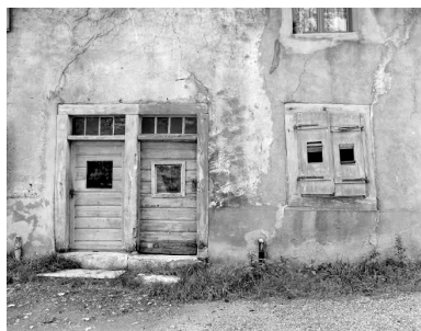
Façade postérieure : détail. Phot. Yves Sancey IVR43_19819000089X
