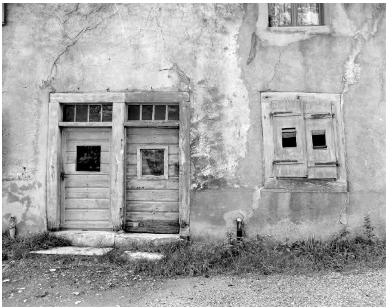
Façade postérieure : détail.
