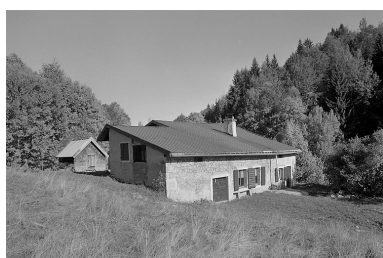
Façade antérieure et face sud-ouest. Phot. Jérôme Mongreville IVR43_19963901353X
