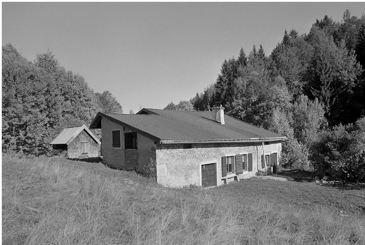
Façade antérieure et face sud-ouest.
