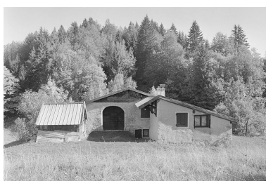
Face sud-ouest. Phot. Jérôme Mongreville IVR43_19963901357X
