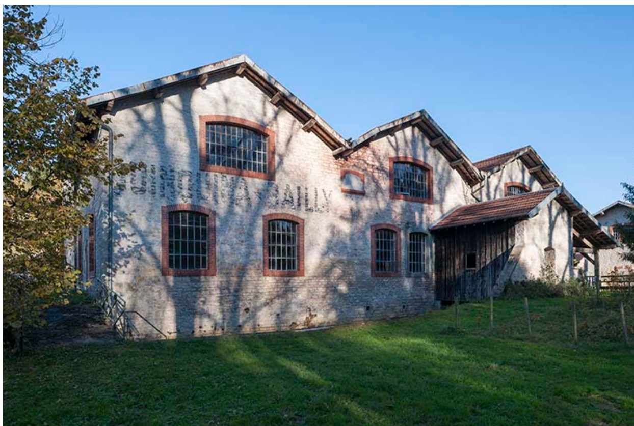
Ateliers ouest vus de trois quarts droite.
