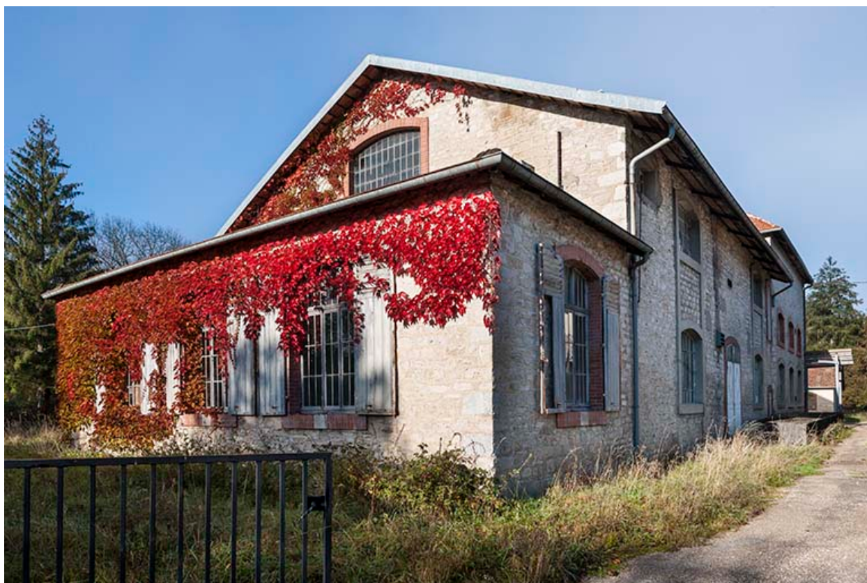
Bâtiment de la distillerie (salles des alambics ?).
