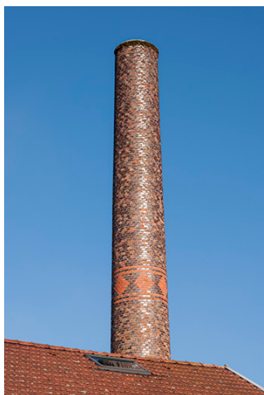
Cheminée de la chaufferie. Phot. Jérôme Mongreville IVR43_20152502525NUC4A
