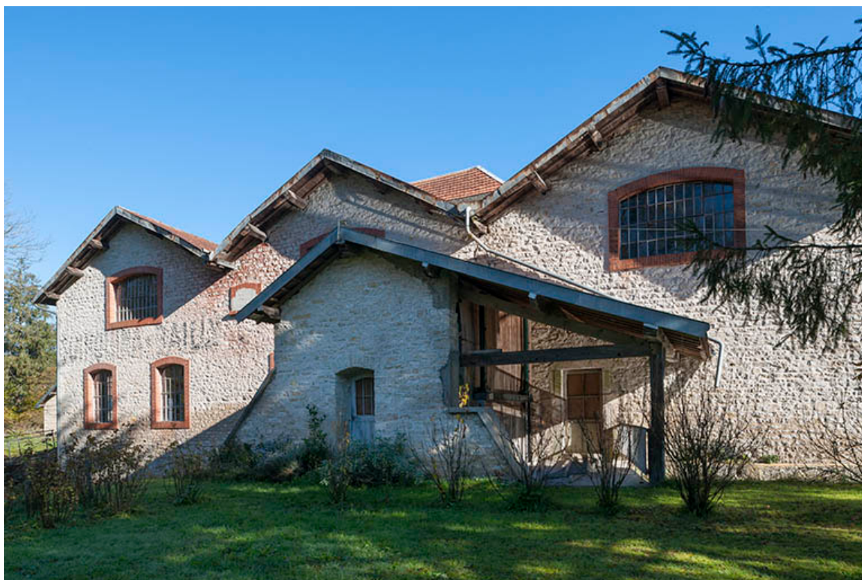
Pignons des bâtiments ouest.
