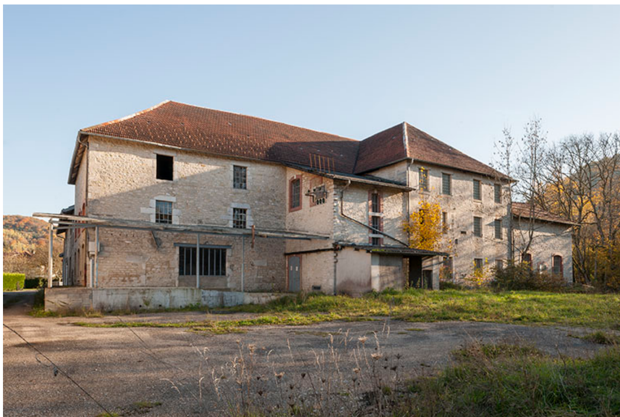
Atelier de fabrication vu depuis le nord.
