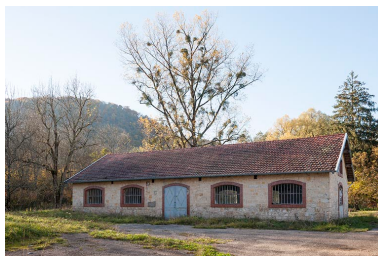
Magasin industriel nord. Phot. Jérôme Mongreville IVR43_20152502517NUC4A
