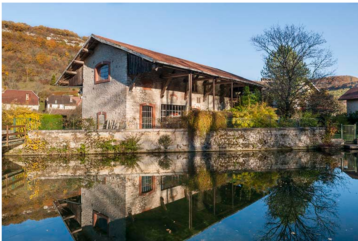
Entrepôt industriel vu depuis le nord-ouest.
