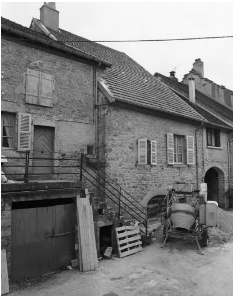
Façade sur l'impasse du Quart d'Amont.
