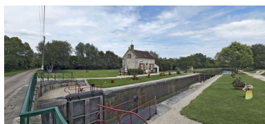
Le site vu du pont sur écluse. Phot. Thierry Kuntz IVR26_20118900084NUC4A
