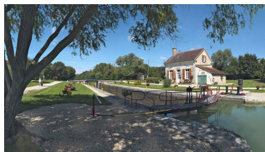
Vue d'ensemble du site. Phot. Thierry Kuntz IVR26_20118900076NUC4A
