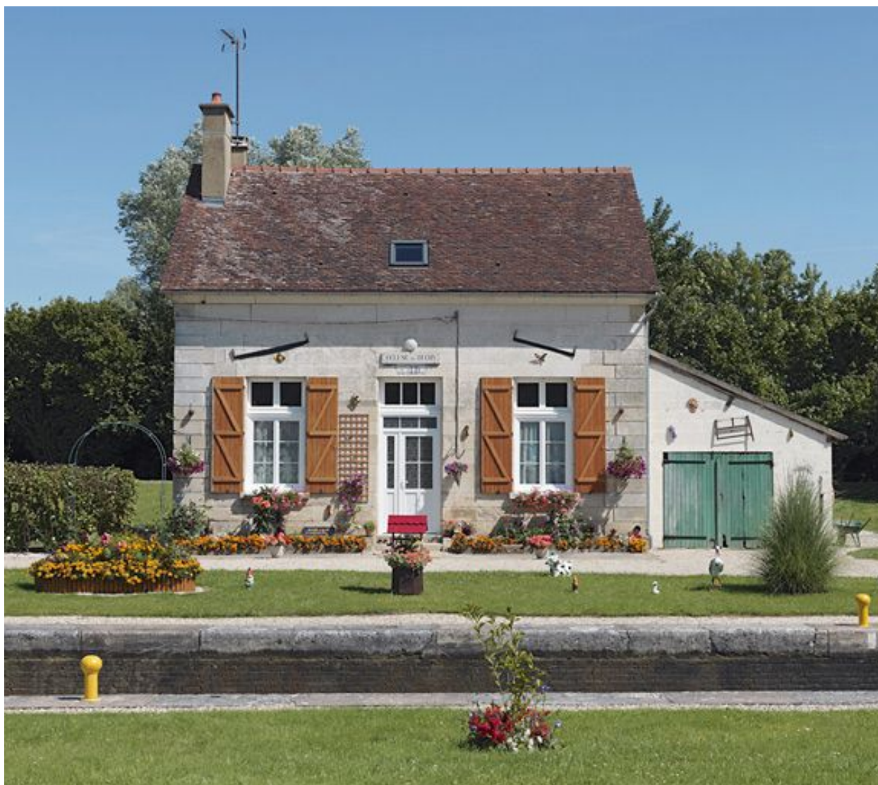
La maison éclusière vue de face.
