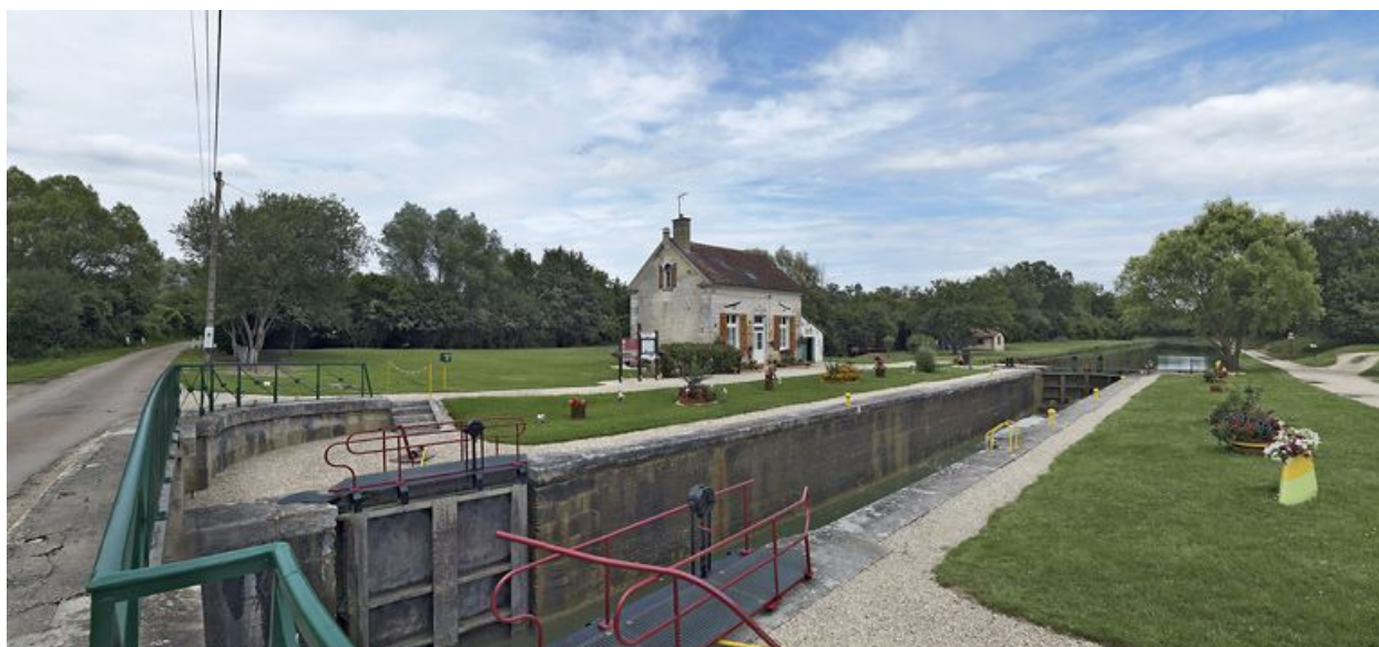
Le site vu du pont sur écluse.
