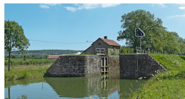
Vue du site d'écluse depuis l'aval. Phot. Pierre-Marie Barbe-Richaud IVR26_20112103686NUC4AQ
