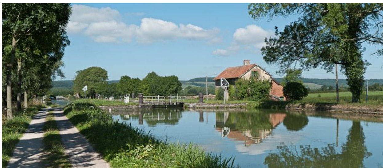
Vue du site d'écluse depuis l'amont.
