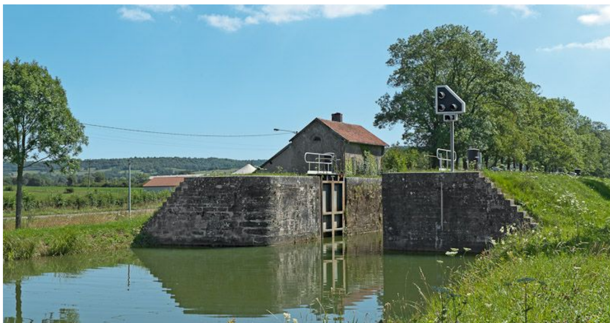
Vue du site d'écluse depuis l'aval.
