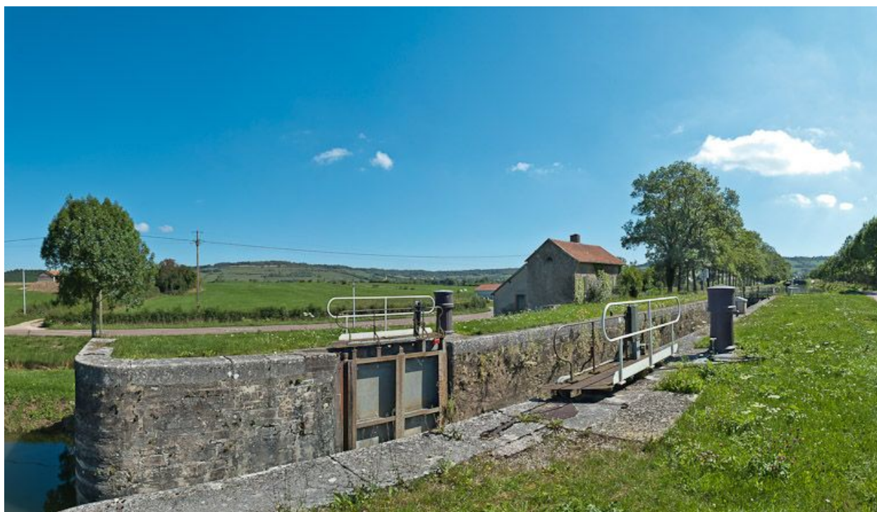
Vue du site d'écluse depuis l'aval.
