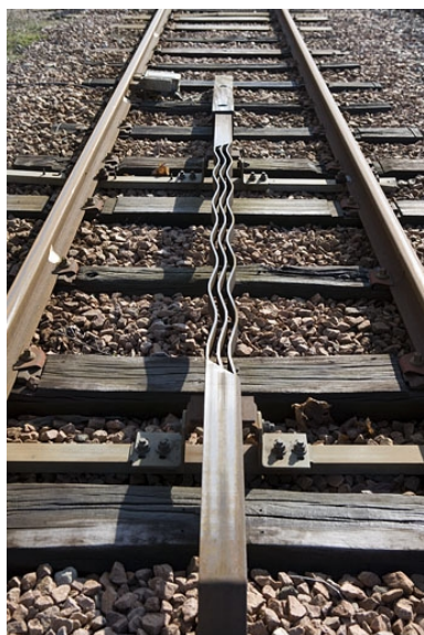
Vue d'ensemble. Phot. Yves Sancey IVR43_20073900047NUCA
