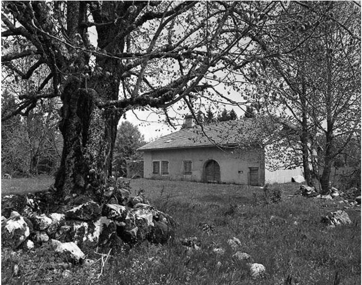
Vue éloignée de la façade postérieure.
