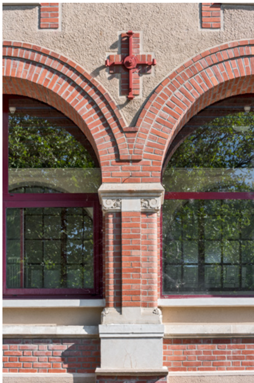
Détail d'une colonne de la galerie ouverte.
