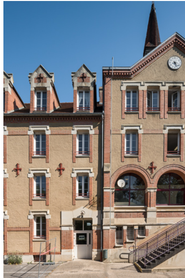
Détail de la jonction entre l'aile ouest et l'aile centrale. Phot. Pierre-Marie Barbe-Richaud IVR26_20238900537NUC4A
