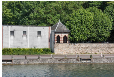
Détail de l'ancien domaine de Saint-Sauveur : à gauche l'atelier de fabrication de palettes, à droite le kiosque installé le long de l'Yonne. Phot. Pierre-Marie Barbe-Richaud IVR26_20238900562NUC4A
