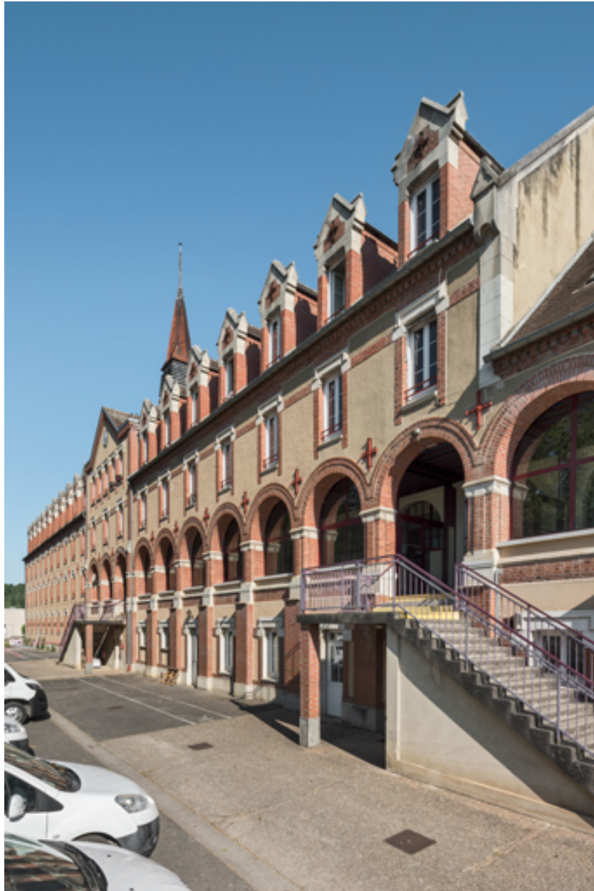
Vue de la façade sud (de trois-quarts).
