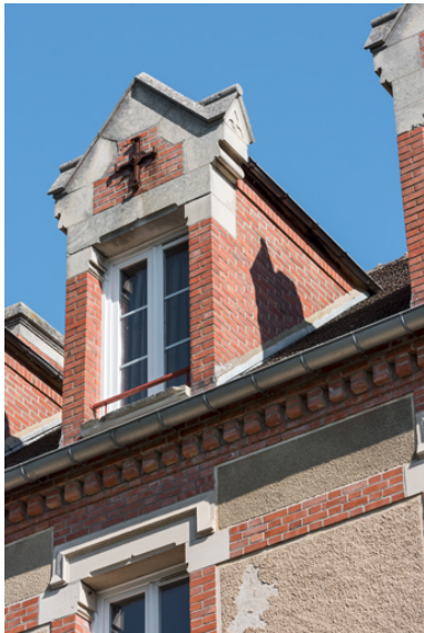
Détail des lucarnes réalisées lors de l'aménagement de l'étage sous comble. Phot. Pierre-Marie Barbe-Richaud IVR26_20238900536NUC4A
