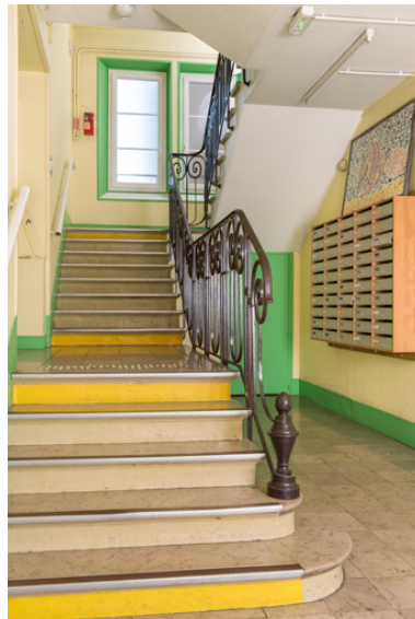
Vue d'un escalier intérieur. Phot. Pierre-Marie Barbe-Richaud IVR26_20238900571NUC4A
