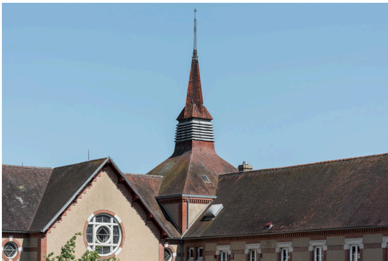
Détail des toitures de la chapelle et du campanile.
