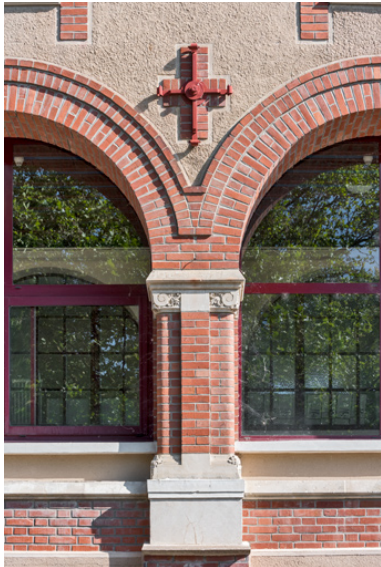
Détail d'une colonne de la galerie ouverte. Phot. Pierre-Marie Barbe-Richaud IVR26_20238900532NUC4A
