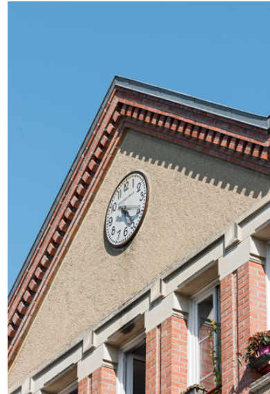
Détail du fronton central avec son décor de denticules. Phot. Pierre-Marie Barbe-Richaud IVR26_20238900535NUC4A
