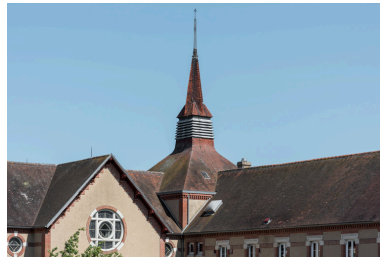
Détail des toitures de la chapelle et du campanile. Phot. Pierre-Marie Barbe-Richaud IVR26_20238900558NUC4A
