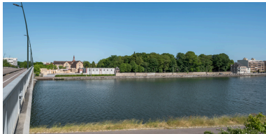
Vue d'ensemble de l'ancien domaine de Saint-Sauveur. Phot. Pierre-Marie Barbe-Richaud IVR26_20238900561NUC4AQ
