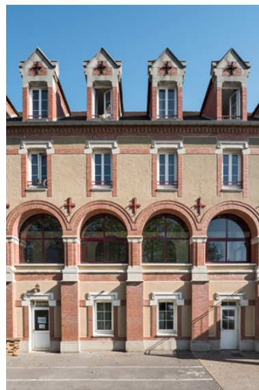
Vue de quatre travées de la façade sud, avec la galerie jouant le rôle de cloître. Phot. Pierre-Marie Barbe-Richaud IVR26_20238900531NUC4A
