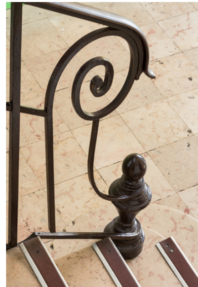
Détail du garde-corps de l'escalier. Phot. Pierre-Marie Barbe-Richaud IVR26_20238900572NUC4A
