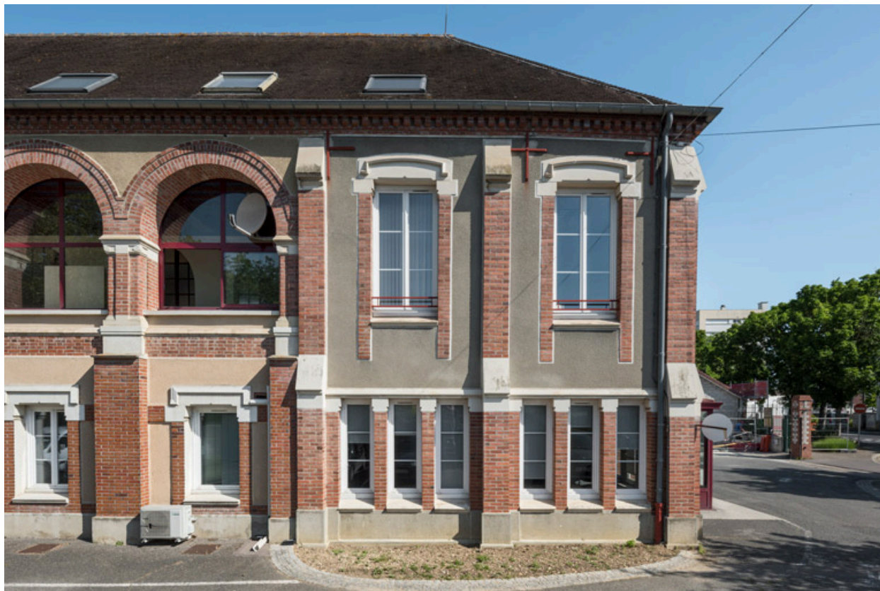
Vue des quatre premières travées de la façade sud de l'aile reconstruite.
