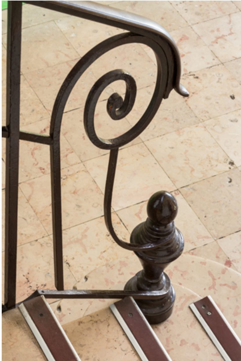
Détail du garde-corps de l'escalier.
