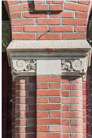
Détail du chapiteau d'inspiration ionique dans la galerie ouverte, de face. Phot. Pierre-Marie Barbe-Richaud IVR26_20238900533NUC4A
