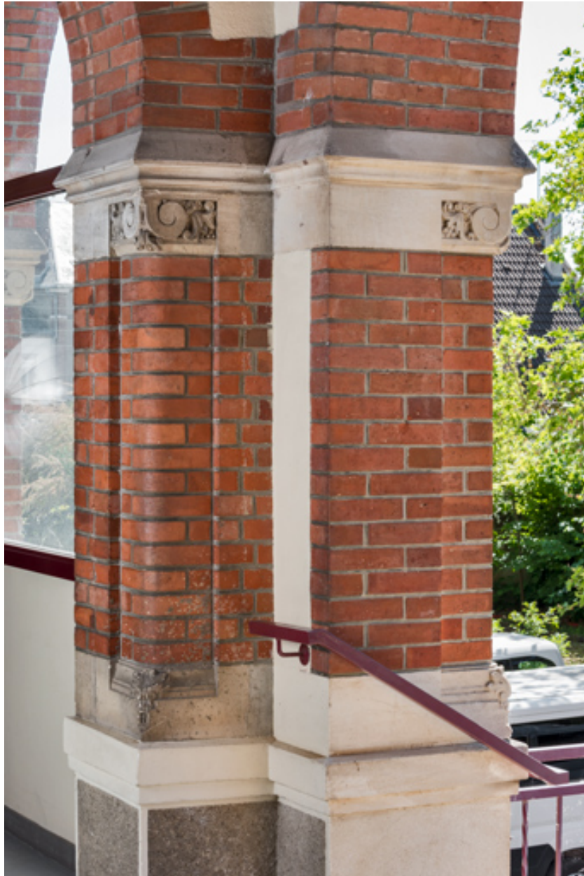
Détail de la colonne de la galerie ouverte (vue depuis la galerie).
