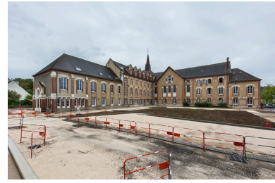
Vue d'ensemble du séminaire : façades nord et est. Phot. Pierre-Marie Barbe-Richaud IVR26_20238901050NUC4A
