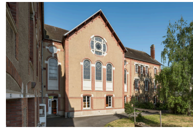
Vue de la façade ouest de l'aile nord. Phot. Pierre-Marie Barbe-Richaud IVR26_20238900563NUC4A
