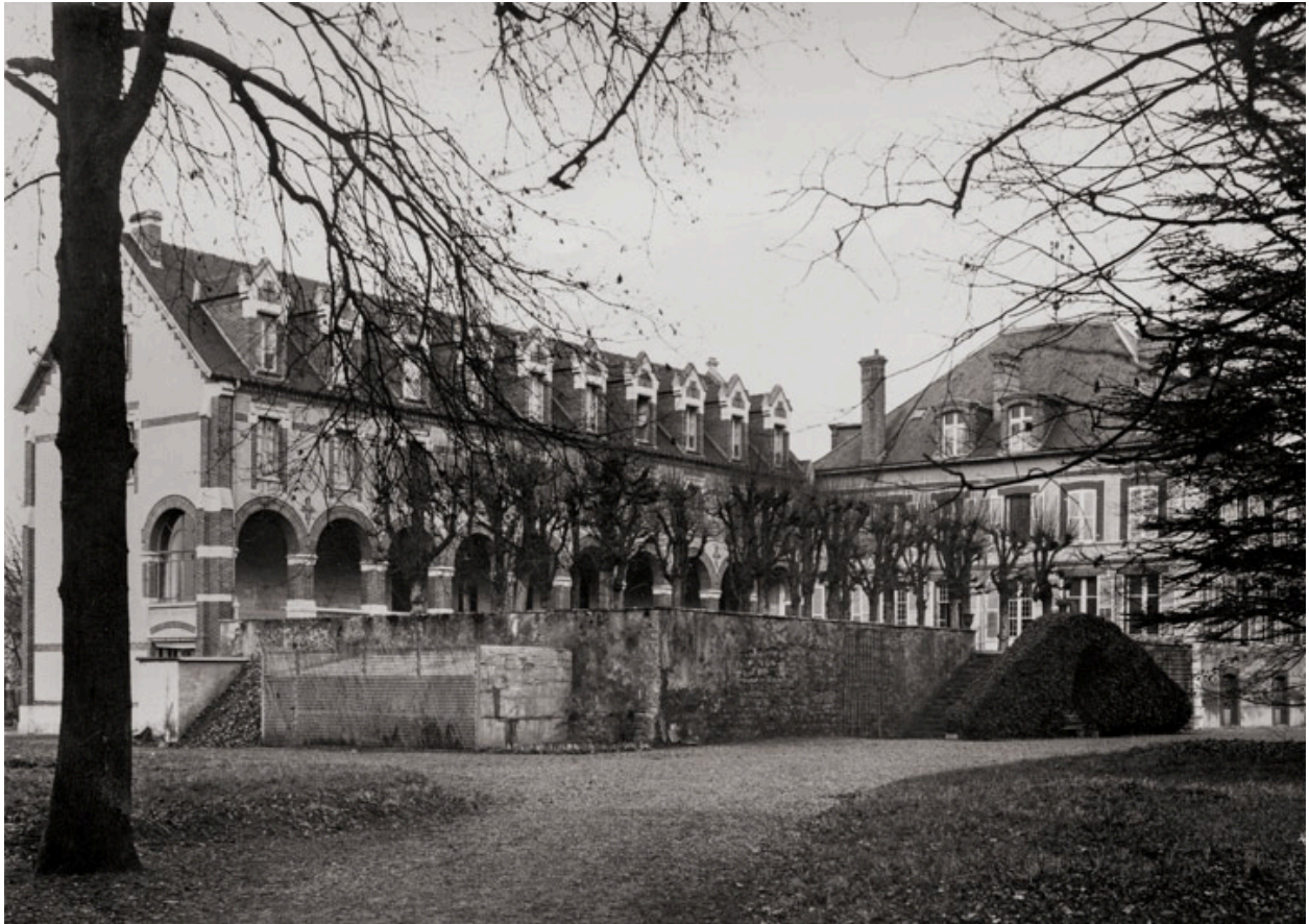
Vue du séminaire avant les travaux d'extension en 1934, depuis le parc.
