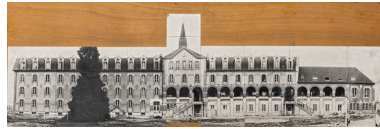
Vue panoramique du séminaire lors des travaux de transformation en Centre d'Aide par le Travail en 1975. Phot. Pierre-Marie Barbe-Richaud, Autr. auteur inconnu IVR26_20238901046NUC2A
