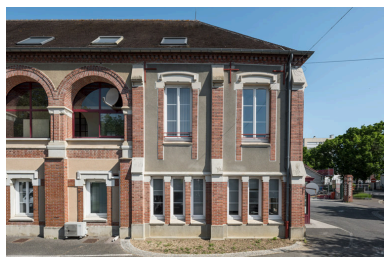
Vue des quatre premières travées de la façade sud de l'aile reconstruite. Phot. Pierre-Marie Barbe-Richaud IVR26_20238900569NUC4A
