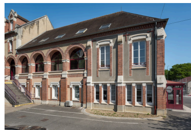
Vue de la façade sud de la partie reconstruite. Phot. Pierre-Marie Barbe-Richaud IVR26_20238900570NUC4A
