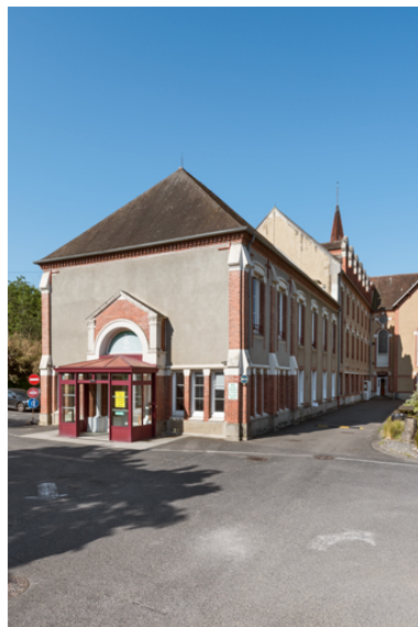
Vue des façades nord et est. Phot. Pierre-Marie Barbe-Richaud IVR26_20238900567NUC4A
