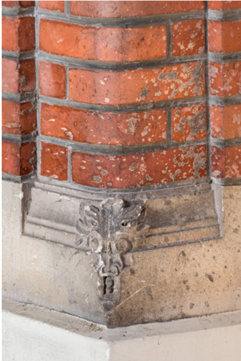
Détail d'une base de colonne de la galerie.
