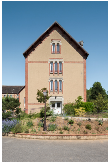
Vue du pignon ouest. Phot. Pierre-Marie Barbe-Richaud IVR26_20238900556NUC4A
