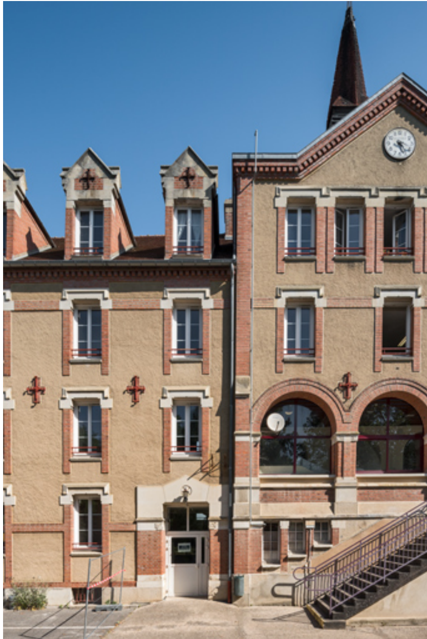
Détail de la jonction entre l'aile ouest et l'aile centrale.
