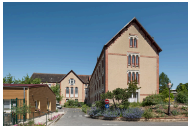
Vue des ailes nord et ouest. Phot. Pierre-Marie Barbe-Richaud IVR26_20238900555NUC4A
