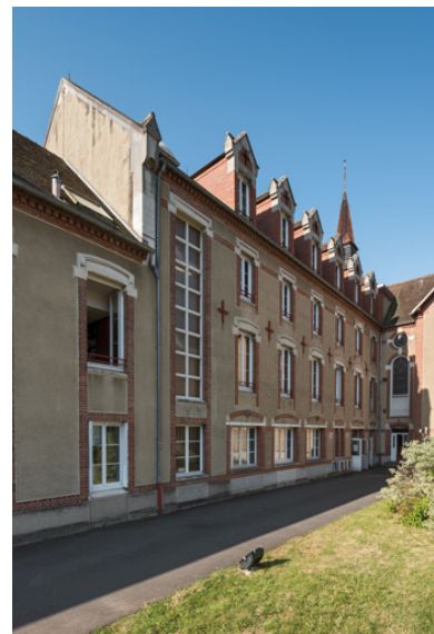
Vue de la façade nord de l'aile est Phot. Pierre-Marie Barbe-Richaud IVR26_20238900564NUC4A
