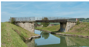
Vue du pont.
