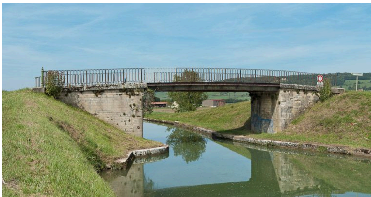
Vue du pont.
