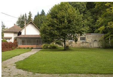
Serre et garage dans le jardin (2020 AI 324). Phot. Jérôme Mongreville IVR43_20082500911NUC2A
