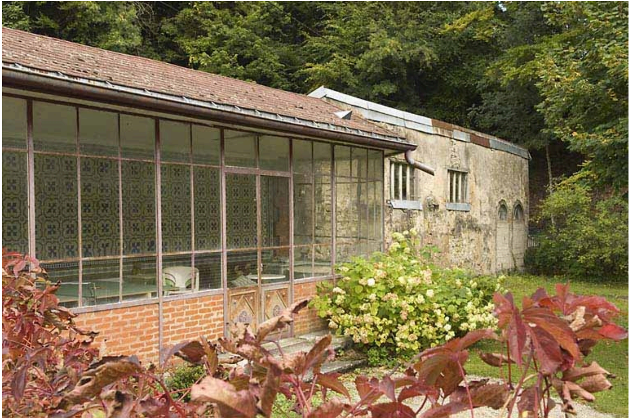
Serre et garage, vus de trois quarts.
