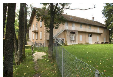
Bâtiment 25 rue des Forges : façade postérieure, de trois quarts gauche. Phot. Jérôme Mongreville IVR43_20082500929NUC2A
