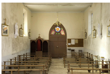
Chapelle rue des Forges : nef vue du chœur. Phot. Jérôme Mongreville IVR43_20082501177NUC2A
