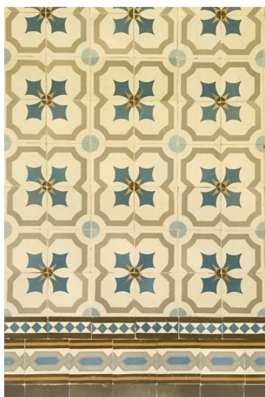
Serre : détail du décor mural de carreaux. Phot. Jérôme Mongreville IVR43_20082500908NUC2A
