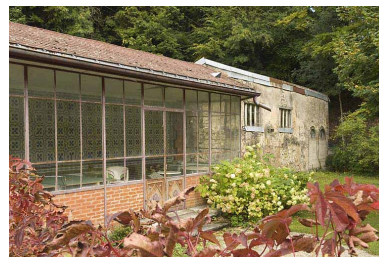
Serre et garage, vus de trois quarts. Phot. Jérôme Mongreville IVR43_20082500916NUC2A
