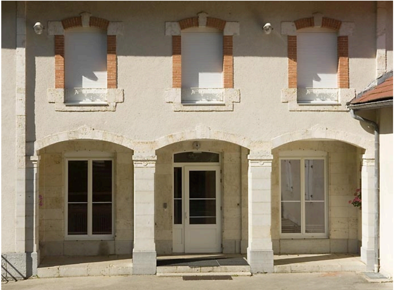
"Grand Château" : baies sur la façade antérieure.
