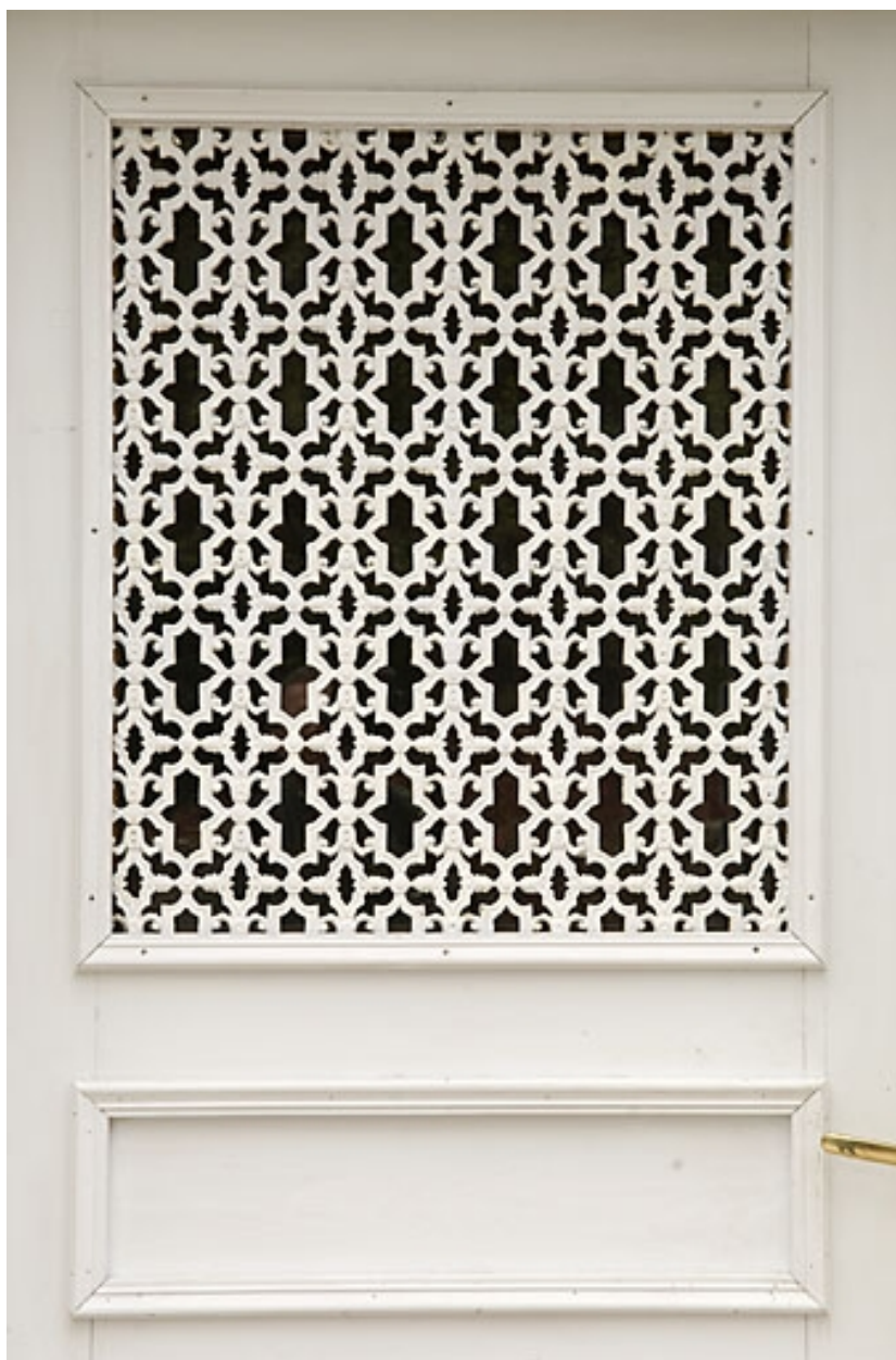
Bâtiment 62-64 rue des Forges : ferronnerie d'une porte (62 rue des Forges).
