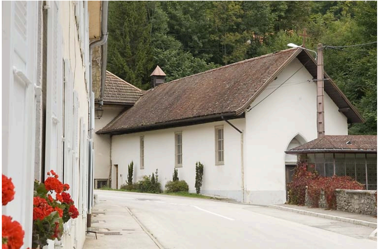
Chapelle rue des Forges (2020 AI 355) : façades antérieure et latérale gauche.
