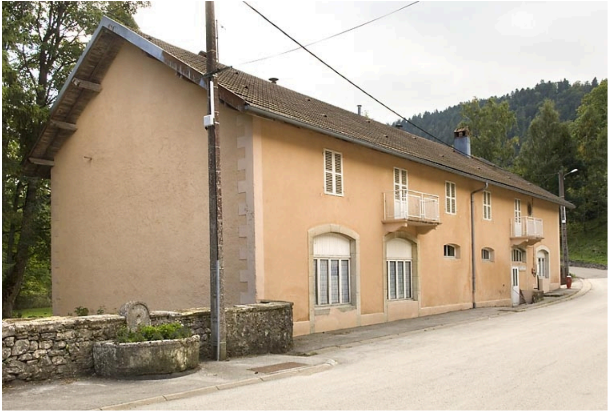
Bâtiment 25 rue des Forges : façade antérieure, de trois quarts gauche.
