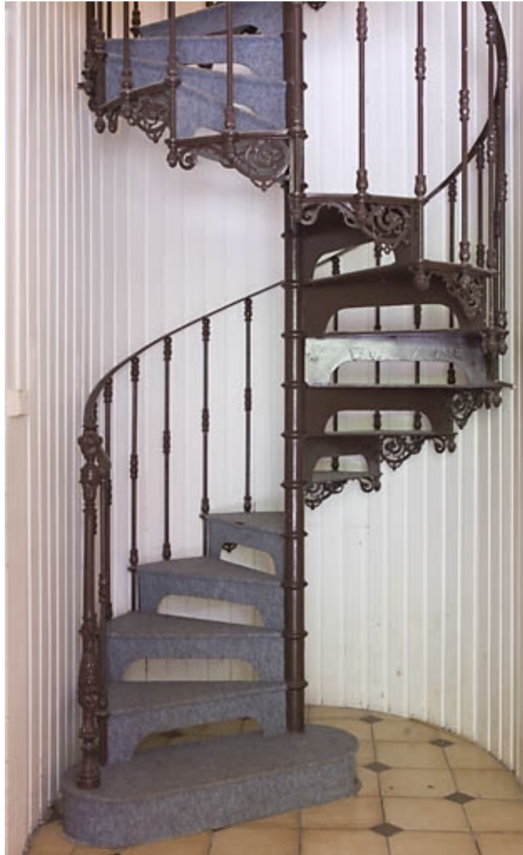
"Grand Château" : escalier métallique en vis.
