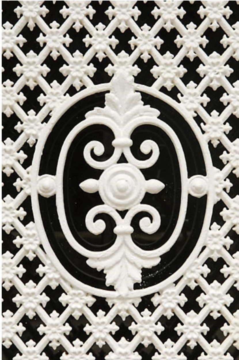
Bâtiment 62-64 rue des Forges : détail de la ferronnerie d'une porte (64 ter rue des Forges).
