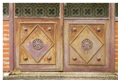
Serre : ferronnerie de la porte. Phot. Jérôme Mongreville IVR43_20082500906NUC2A
