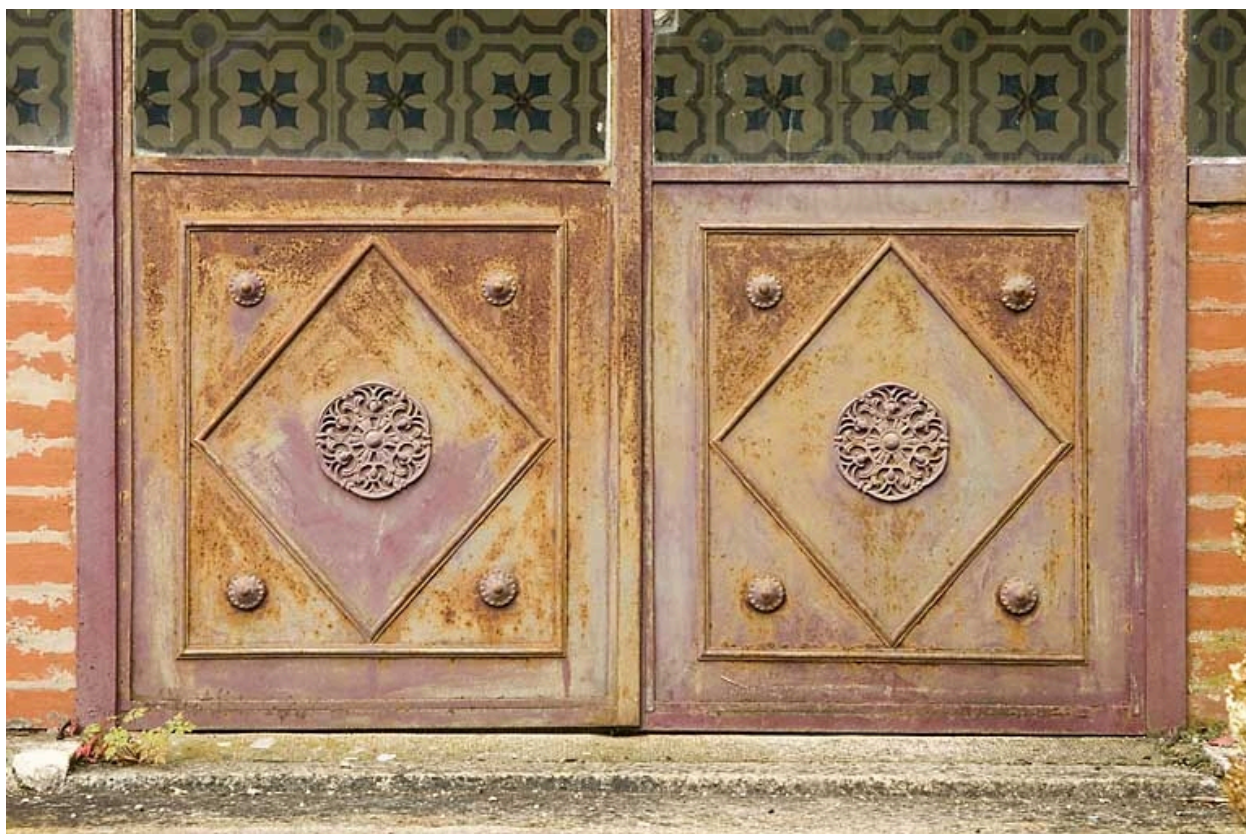
Serre : ferronnerie de la porte.
