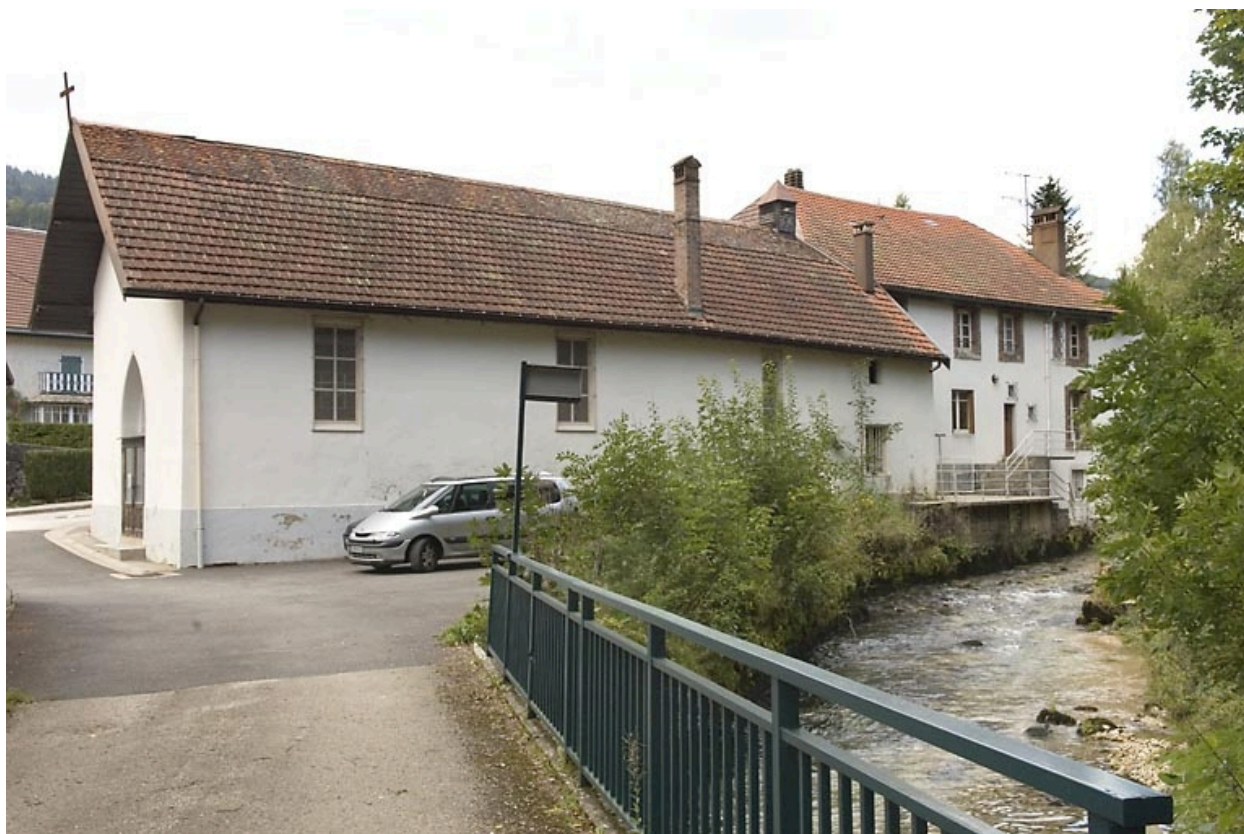
Chapelle rue des Forges : façade latérale droite.
