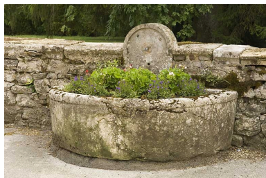
Fontaine contre le mur du jardin, face au bâtiment 62-64 rue des Forges. Phot. Jérôme Mongreville IVR43_20082500903NUC2A
