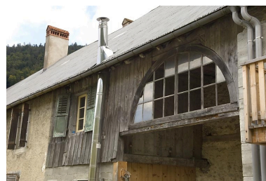
Bâtiment 62-64 rue des Forges : portail sur la façade postérieure. Phot. Jérôme Mongreville IVR43_20082500927NUC2A
