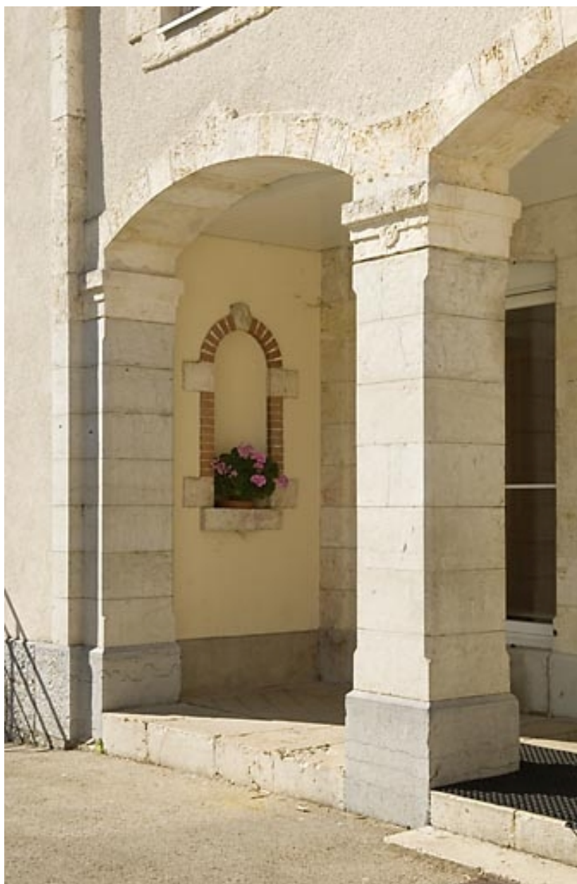
"Grand Château" : détail de la galerie.
