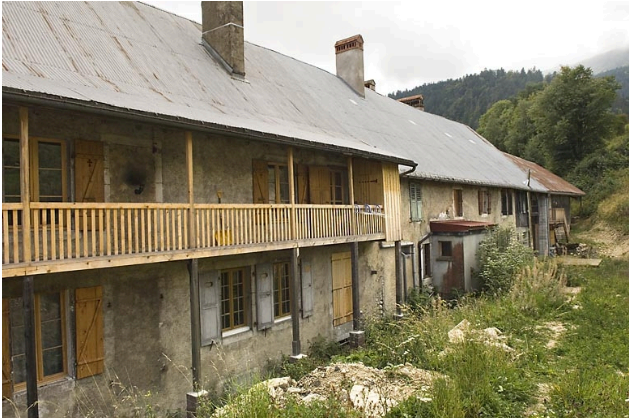
Bâtiment 62-64 rue des Forges : façade postérieure, de trois quarts gauche.
