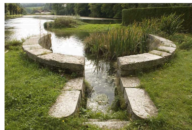
Embarcadère sur l'étang nord. Phot. Jérôme Mongreville IVR43_20082500928NUC2A
