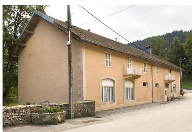
Bâtiment 25 rue des Forges : façade antérieure, de trois quarts gauche. Phot. Jérôme Mongreville IVR43_20082500931NUC2A
