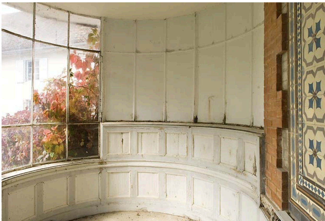
Serre : intérieur (extrémité nord-ouest).
