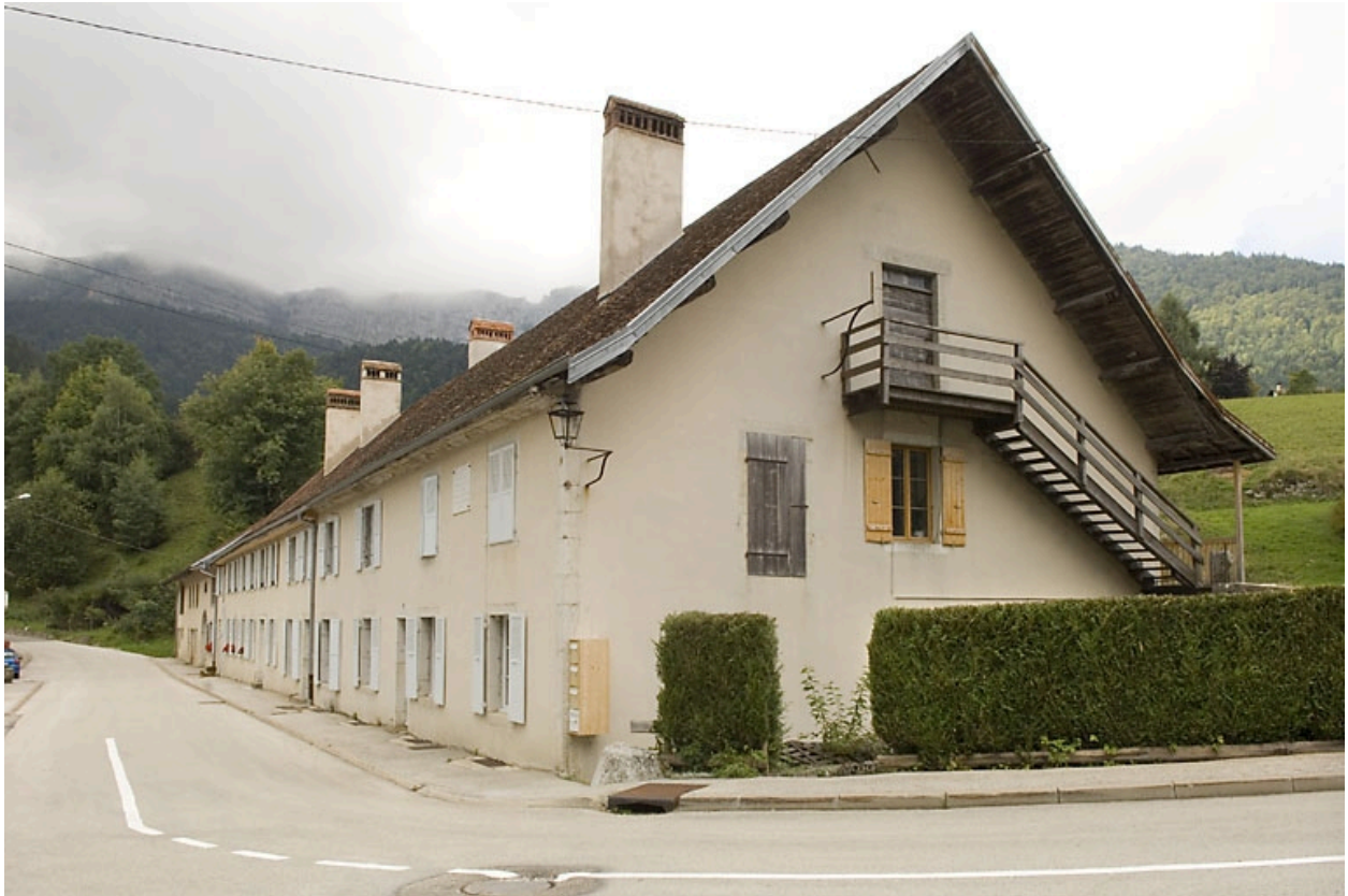
Ancien bâtiment des forges puis logement patronal (62-64 rue des Forges, 2020 Ai 94, 232).
