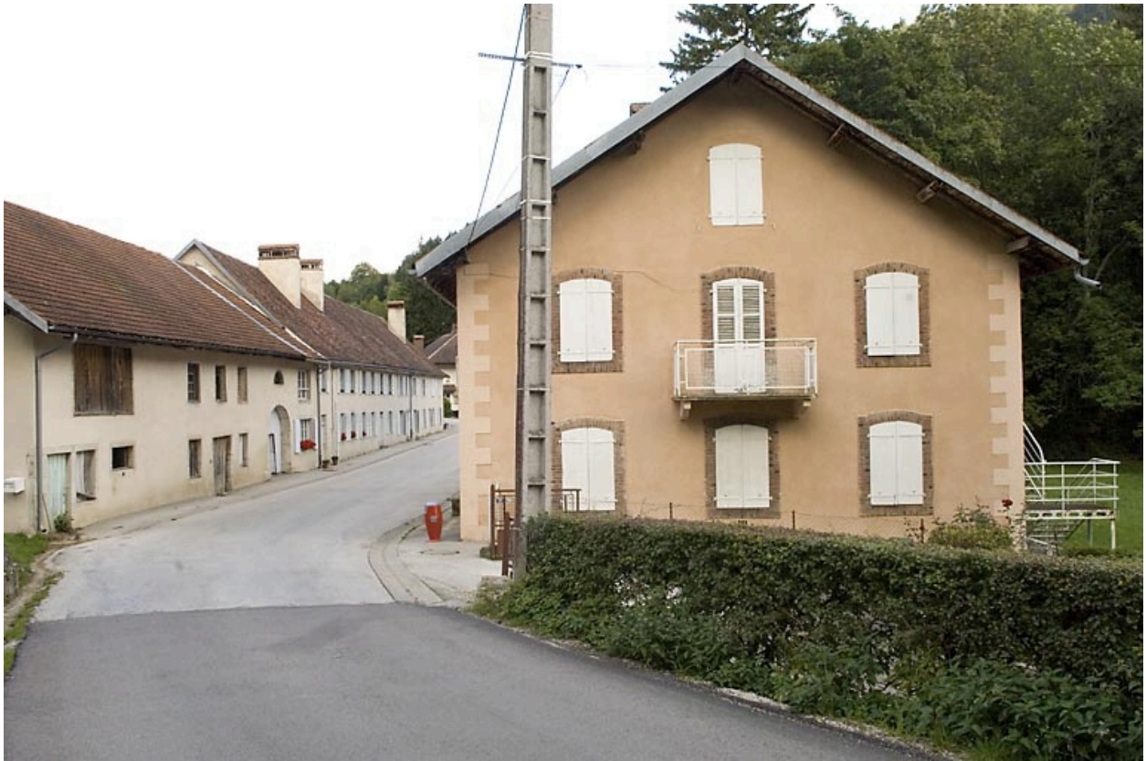
Bâtiment 25 rue des Forges (2020 AI 326) : façade latérale droite.
