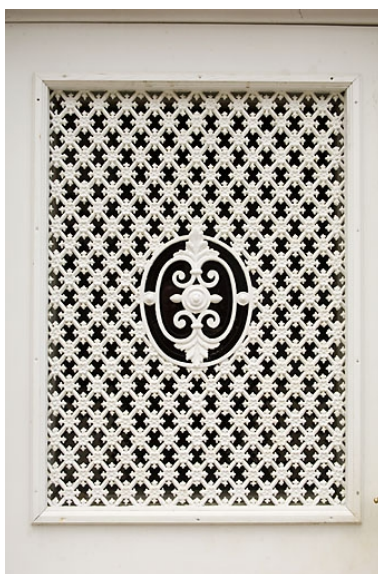
Bâtiment 62-64 rue des Forges : ferronnerie d'une porte (64 ter rue des Forges). Phot. Jérôme Mongreville IVR43_20082500925NUC2A
