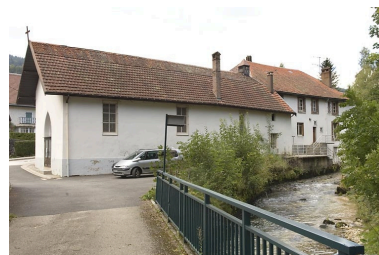
Chapelle rue des Forges : façade latérale droite. Phot. Jérôme Mongreville IVR43_20082501083NUC2A
