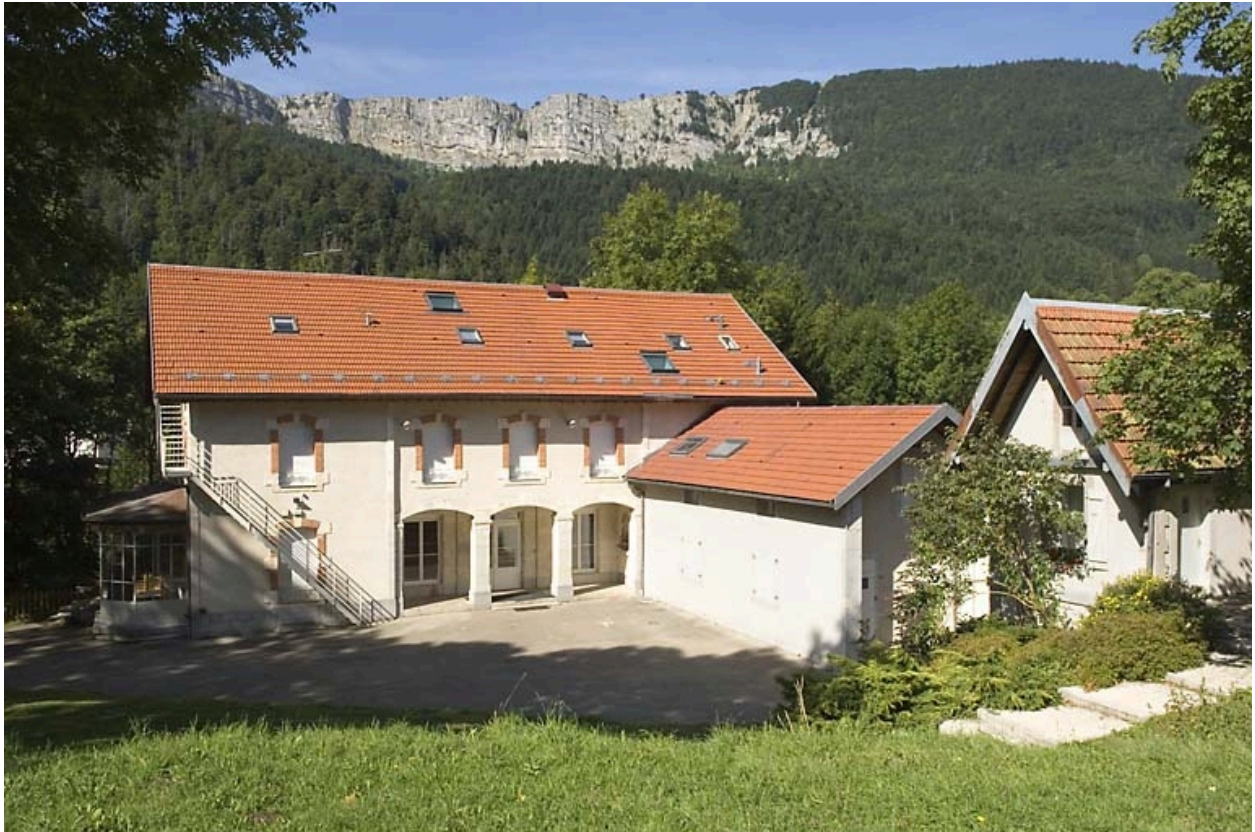
Logement patronal dit le "Grand Château" (2020 AI 47) : façade antérieure.
