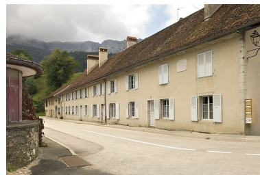
Bâtiment 62-64 rue des Forges, vu de trois quarts droite. Phot. Jérôme Mongreville IVR43_20082500919NUC2A
