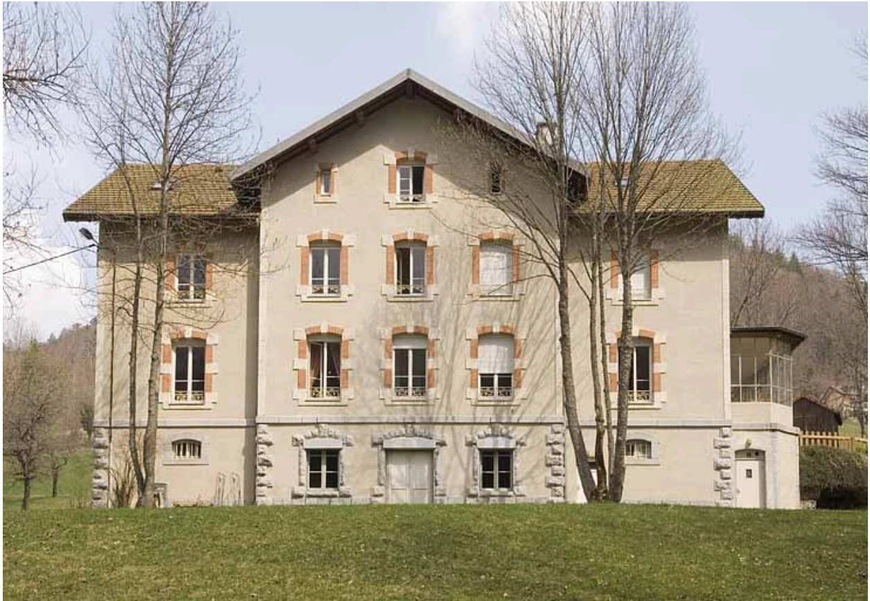
Logement patronal dit le "Grand Château" (2020 AI 47) : façade postérieure.
