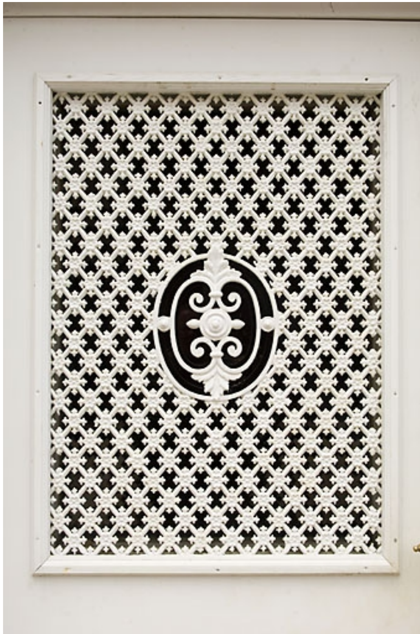
Bâtiment 62-64 rue des Forges : ferronnerie d'une porte (64 ter rue des Forges).
