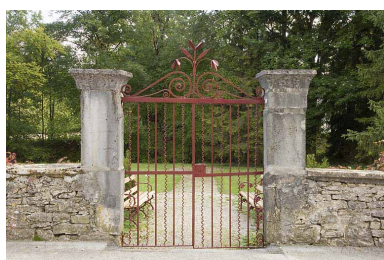
Grille du jardin, face au bâtiment 62-64 rue des Forges. Phot. Jérôme Mongreville IVR43_20082500914NUC2A
