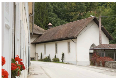
Chapelle rue des Forges (2020 AI 355) : façades antérieure et latérale gauche. Phot. Jérôme Mongreville IVR43_20082501082NUC2A
