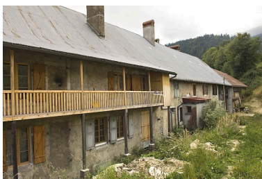
Bâtiment 62-64 rue des Forges : façade postérieure, de trois quarts gauche. Phot. Jérôme Mongreville IVR43_20082500926NUC2A
