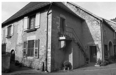
Ferme située rue de la Creuse. Phot. Bernard Lardière IVR43_19797000185Z
