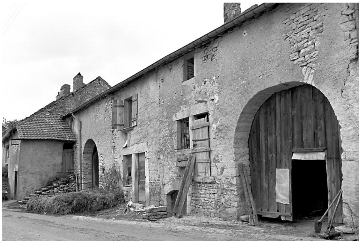
Ferme située rue Longereaux.
