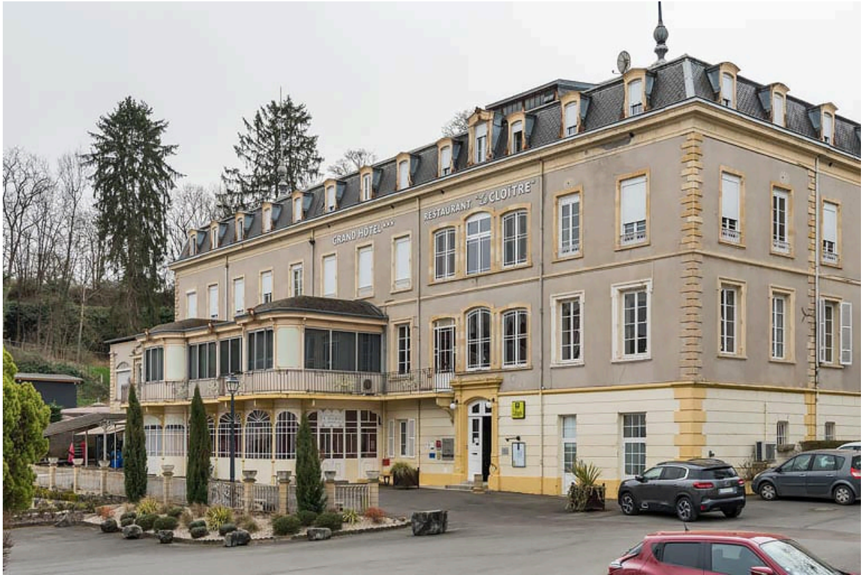
Aile ouest, façade.
