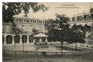
Cour, vue ancienne. Autr. auteur inconnu IVR26_20207100062NUC4A
