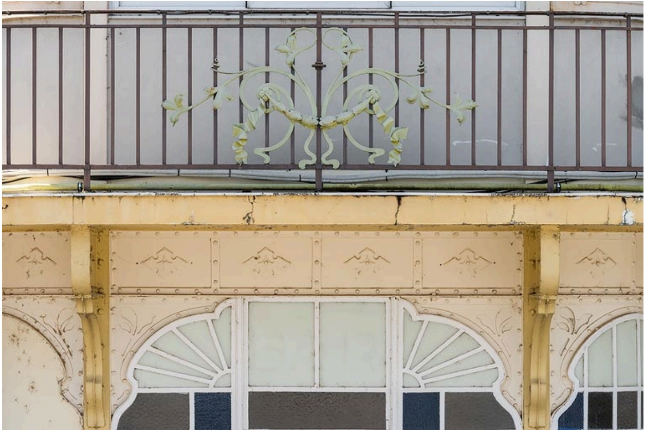
Aile ouest, salle à manger, détail.
