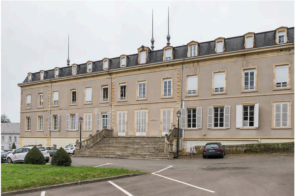
Aile nord, façade.
