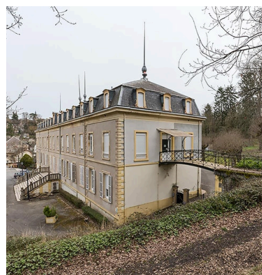
Aile nord, vue d'ensemble. Phot. Pierre-Marie Barbe-Richaud IVR26_20227100026NUC4A
