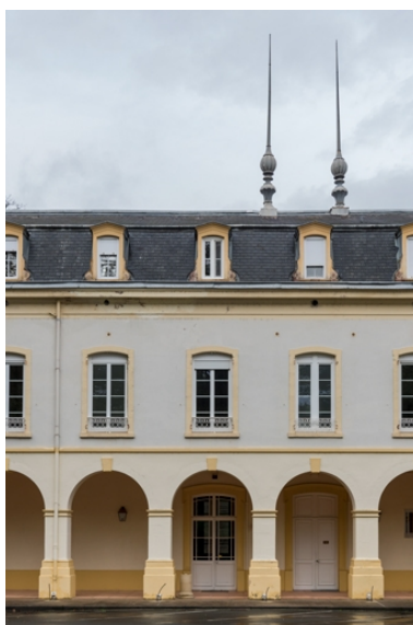
Cour, détail de l'aile nord. Phot. Pierre-Marie Barbe-Richaud IVR26_20227100172NUC4A
