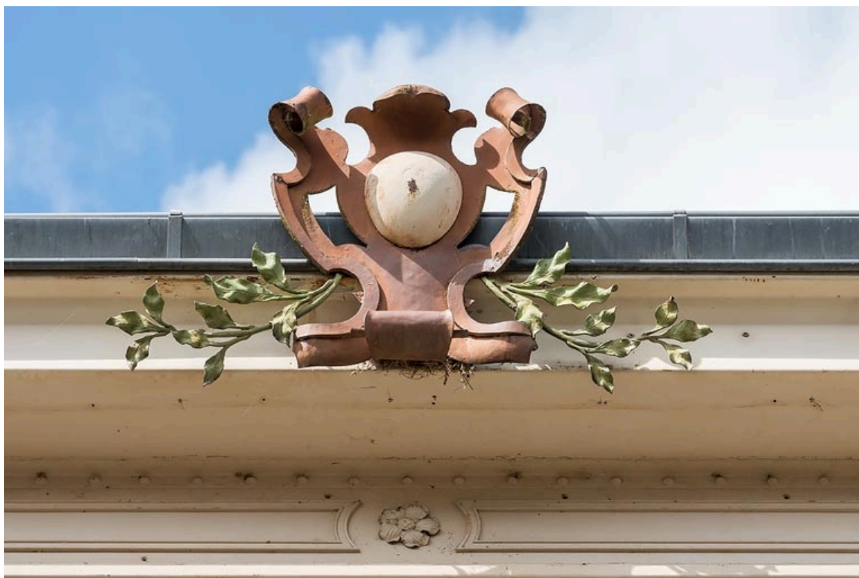
Aile ouest, salle à manger, détail.
