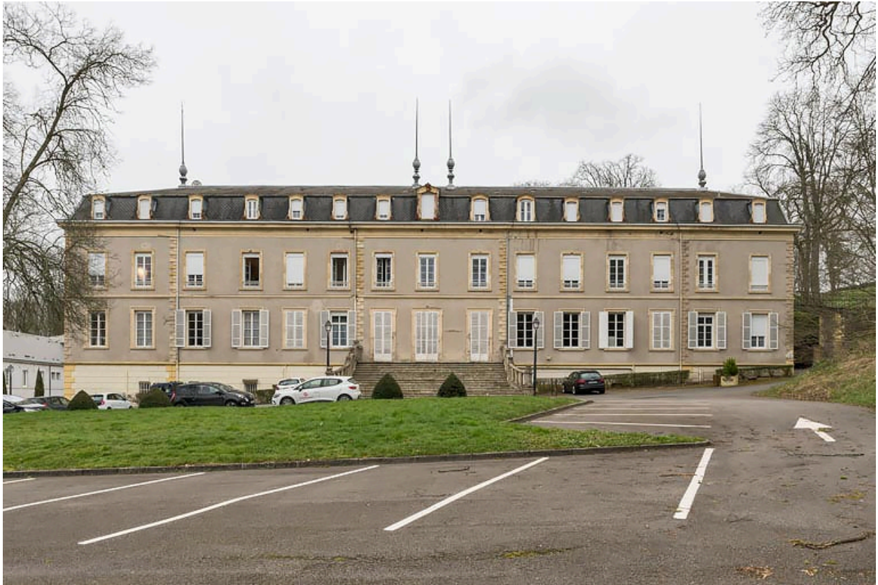
Aile nord, façade.
