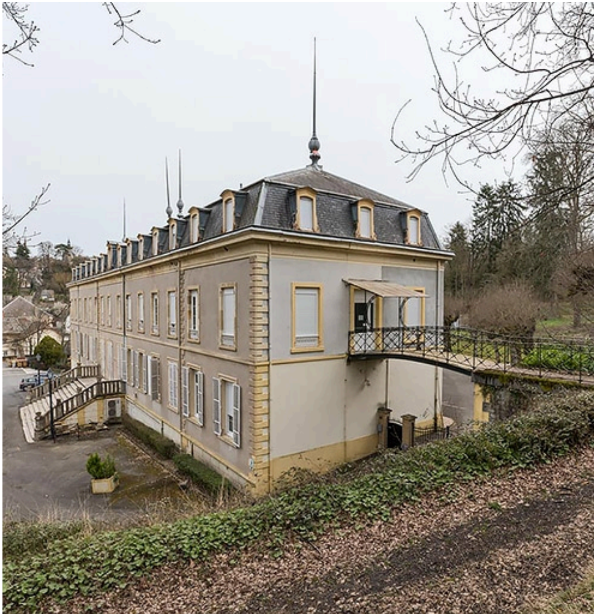
Aile nord, vue d'ensemble.
