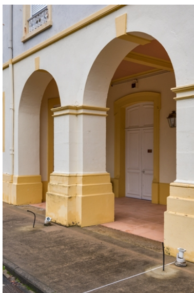
Cour, détail de l'aile nord (arcade en pierre à droite, arcade en ciment à gauche). Phot. Pierre-Marie Barbe-Richaud IVR26_20227100175NUC4A
