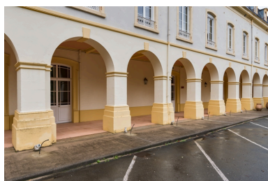
Cour, détail de l'aile nord. Phot. Pierre-Marie Barbe-Richaud IVR26_20227100174NUC4A
