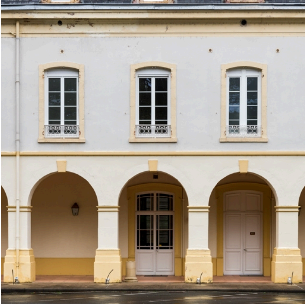
Cour, détail de l'aile nord.
