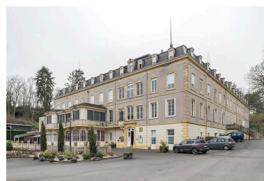
Aile ouest, vue d'ensemble. Phot. Pierre-Marie Barbe-Richaud IVR26_20227100030NUC4A
