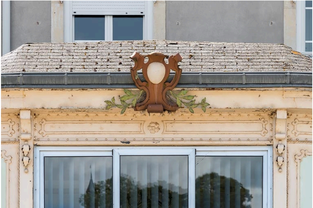
Aile ouest, salle à manger, détail.
