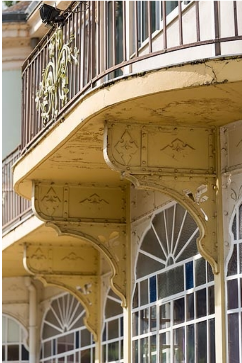
Aile ouest, salle à manger, détail.
