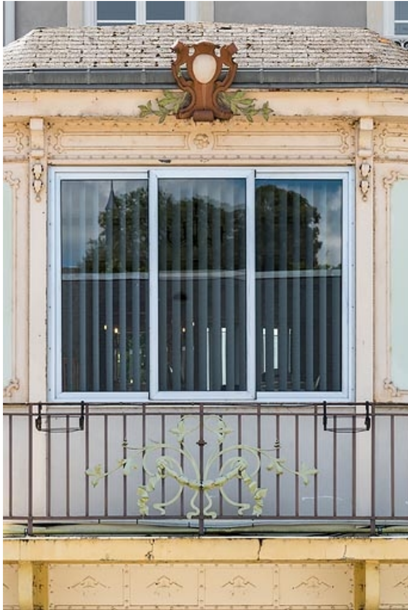
Aile ouest, salle à manger, détail.
