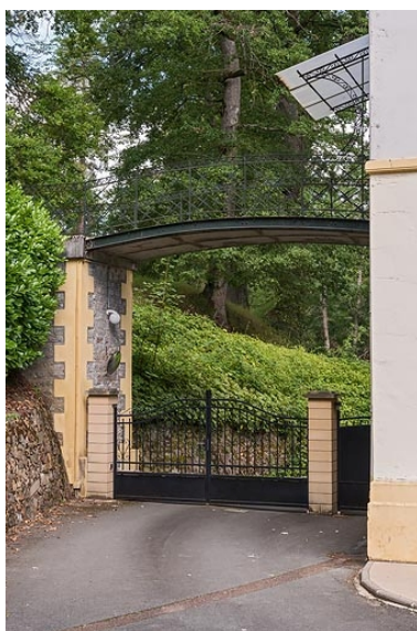
Accès actuel à la cour. Phot. Pierre-Marie Barbe-Richaud IVR26_20217100195NUC4A
