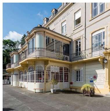
Aile ouest, salle à manger. Phot. Pierre-Marie Barbe-Richaud IVR26_20217100189NUC2A
