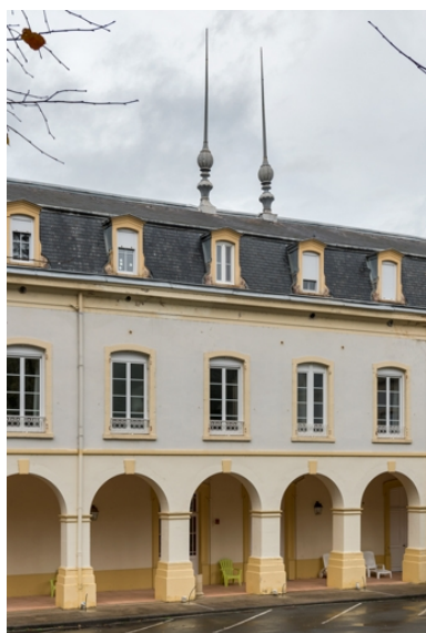
Cour, détail de l'aile nord. Phot. Pierre-Marie Barbe-Richaud IVR26_20227100171NUC4A
