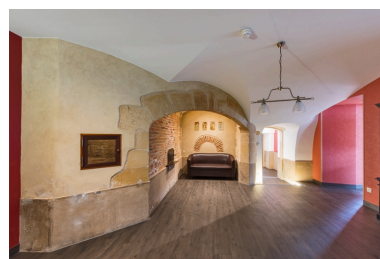
Vue intérieure du rez-de-chaussée. Phot. Pierre-Marie Barbe-Richaud IVR26_20227100180NUC4A
