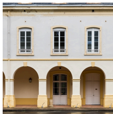
Cour, détail de l'aile nord. Phot. Pierre-Marie Barbe-Richaud IVR26_20227100173NUC2A
