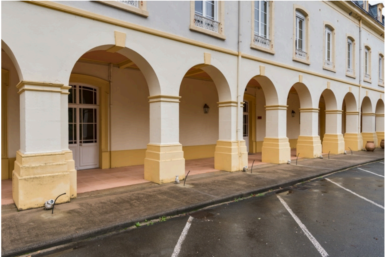
Cour, détail de l'aile nord.
