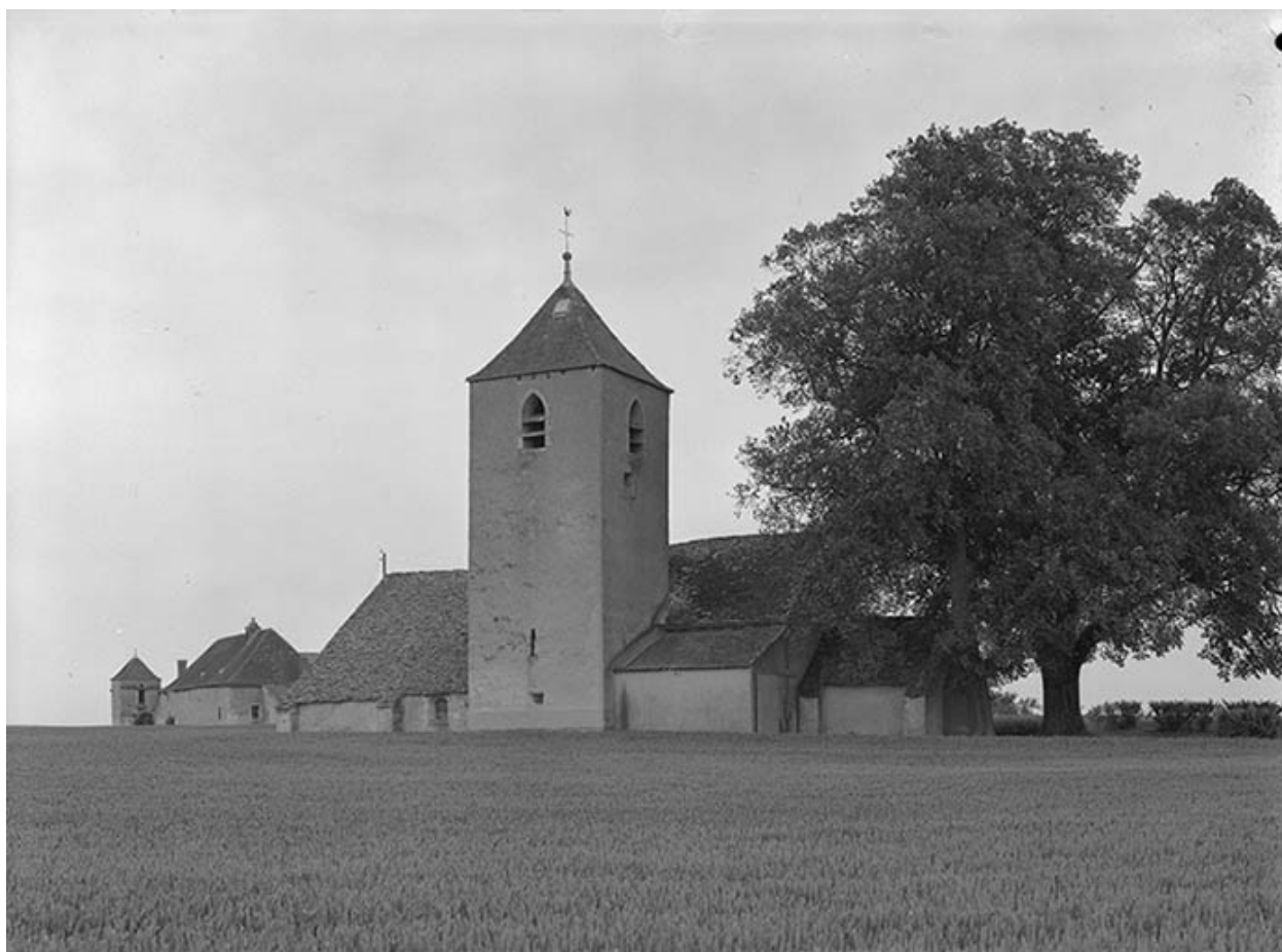
Vue générale côté nord-est (bas-côté et chevet).
