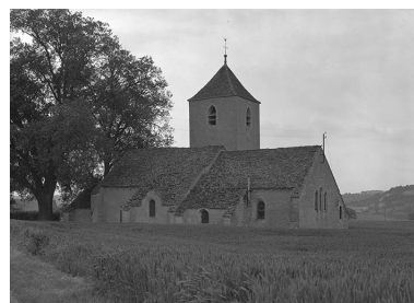
Vue générale côté sud, avec clocher. Phot. Michel Thierry IVR26_19748900293V
