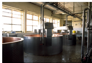
Cuves Chalon Mégard. Phot. Jérôme Mongreville IVR43_19953900220ZA
