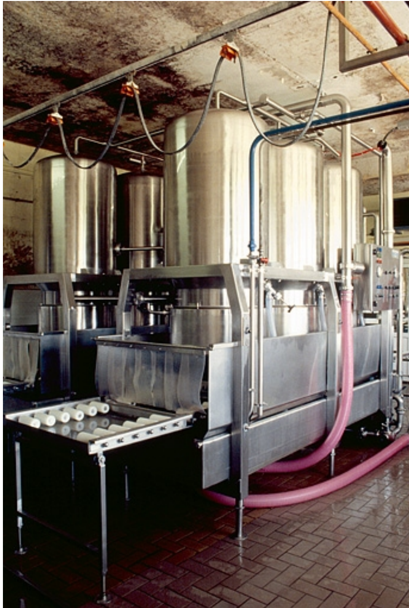
Cloches de l'installation de soutirage sous vide.
